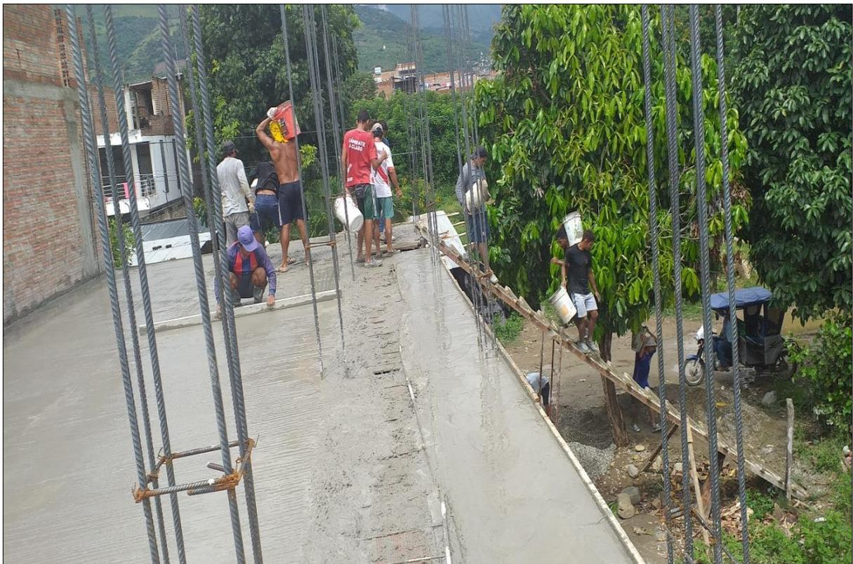
Concreto  $f'c = 210 \text{ kg/cm}^2$  en Losa Aligerada
