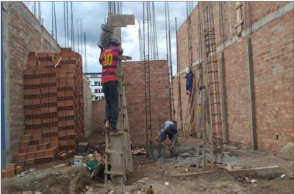
Concreto  $f'c = 210 \text{ kg/cm}^2$  en Columnas (típicas)
