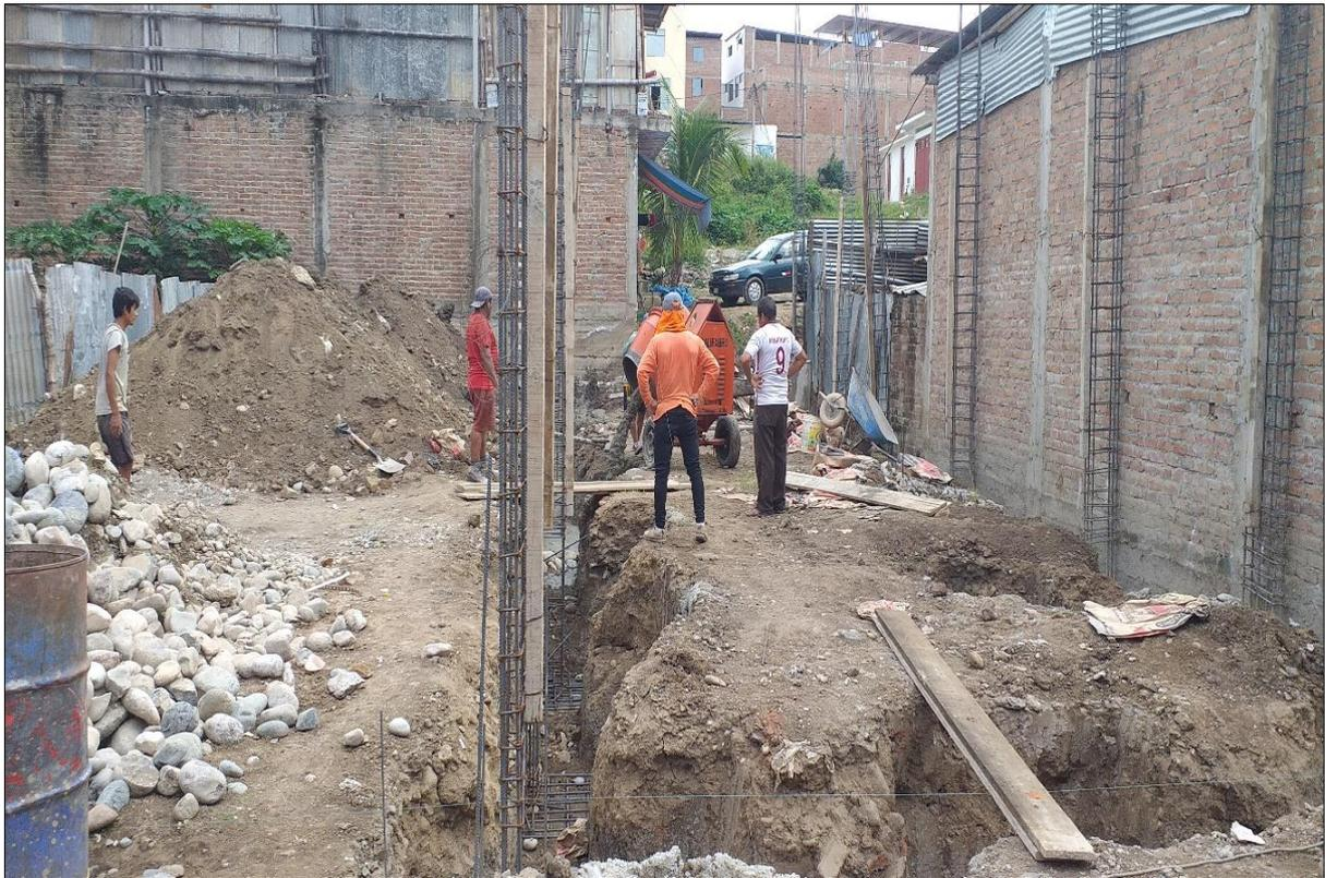
Concreto  $f'c = 175 \text{ kg/cm}^2$  en Zapatas
