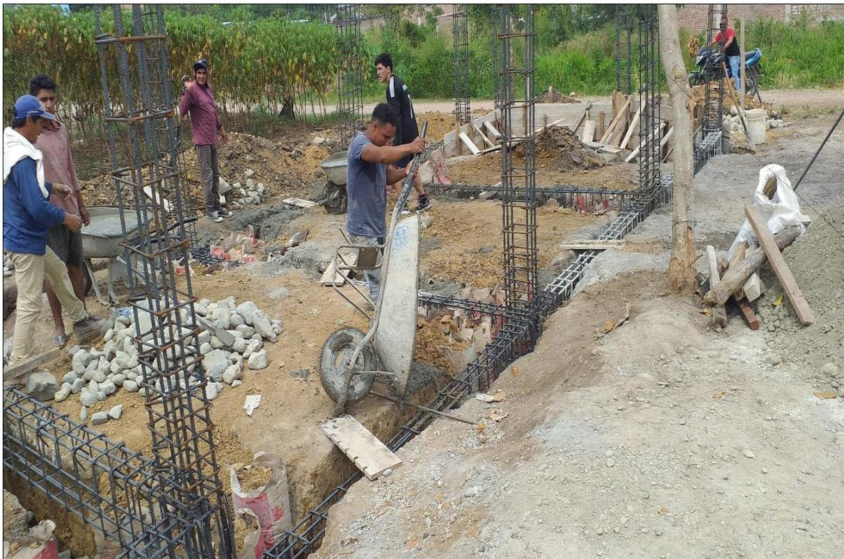
Concreto  $f'c = 210 \text{ kg/cm}^2$  en Vigas de Cimentación
