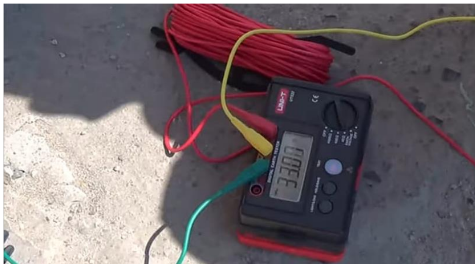
Medida de resistividad del puesta a tierra
