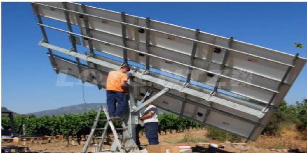
Figura 21. Instalación de seguidor solar Fuente. Valdiviezo (2014)
