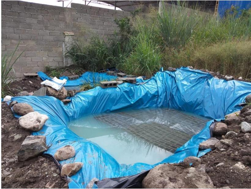
Imagen N°07. Pozas de curación de los bloques de concreto.
