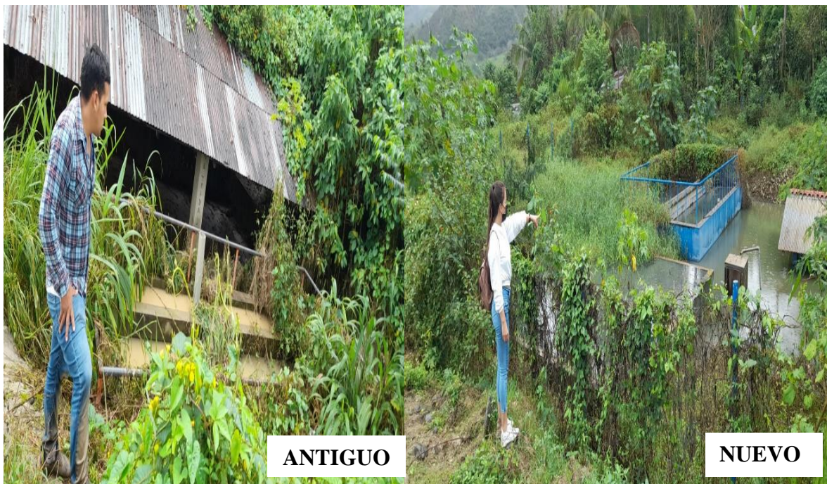
Figura 14. Fotografías del antiguo y nuevo tanque Imhoff del C.P. Puerto Chinchipe.
