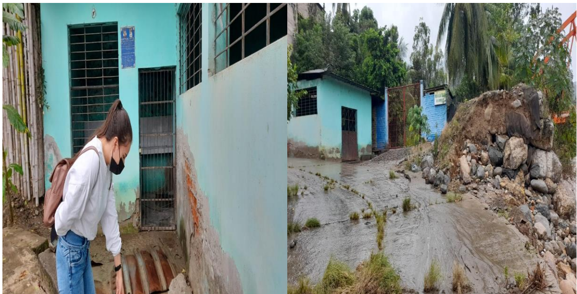
Figura 20. Camal municipal ubicado aproximadamente a 7 m del río.
