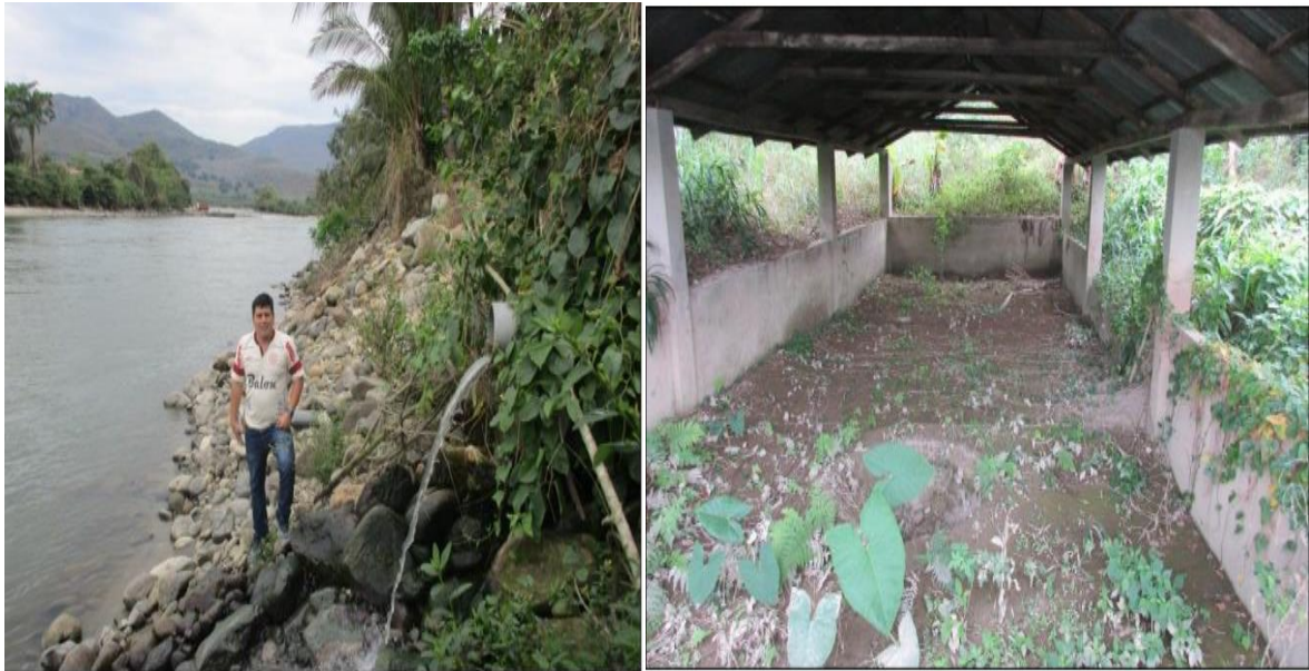
Figura 15. Aguas residuales vertidas directamente al río Chinchipe y tanque Imhoff antiguo.
