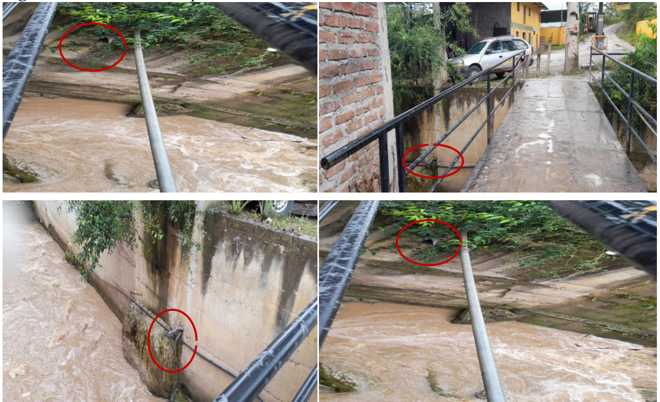
Figura 19. Tubos utilizados para la desembocadura de los residuos de las mecánicas.
