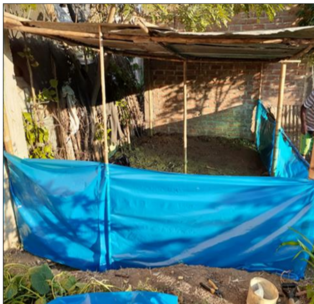
Acondicionamiento del terreno.
