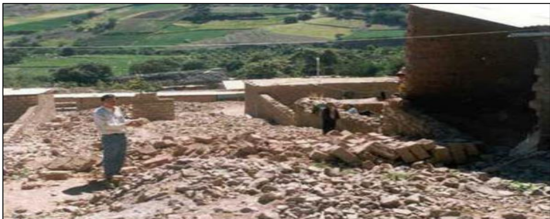
Vivienda cuyos Muros de Adobe han Colapsado por Volteo
