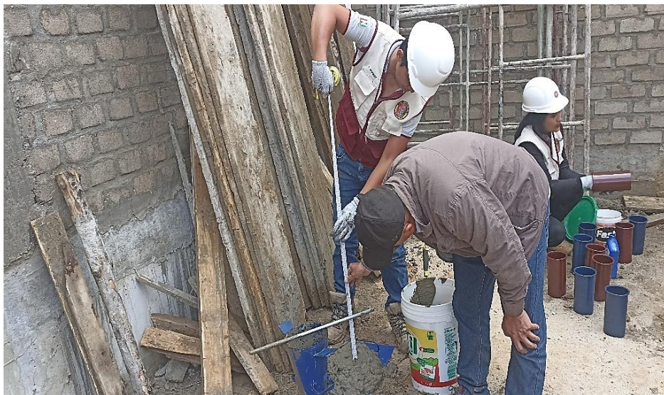
Fotografía 13 Ensayo asentamiento en la mezcla.
