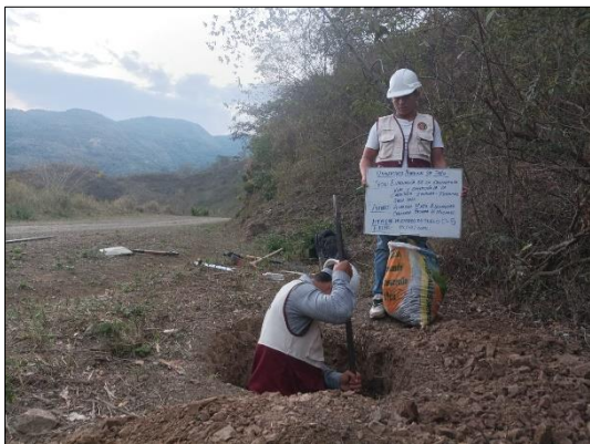
Elaboración de calicata N° 5
