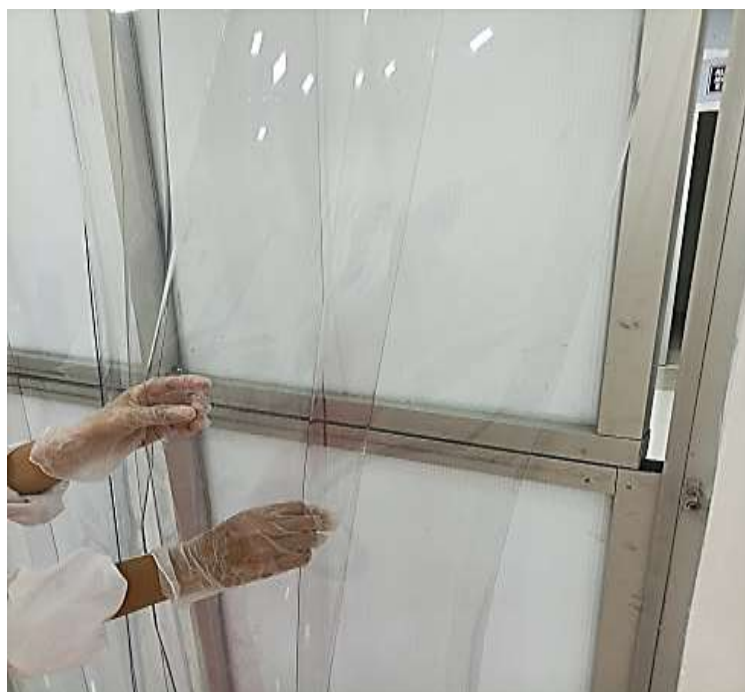
Cortinas de protección en puertas
