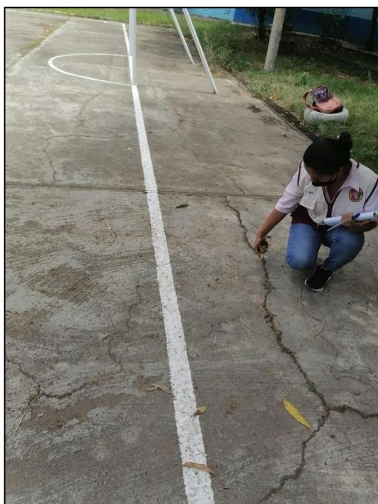
**Fotografía 23:** Losa dividida de severidad media
