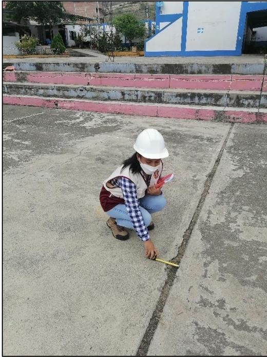
**Fotografía 40:** Descascamiento de junta de severidad baja
