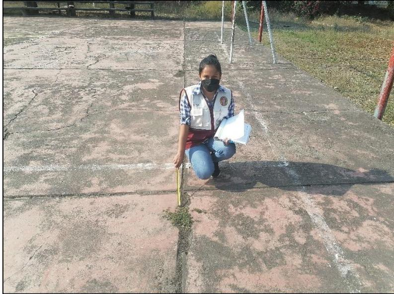
**Fotografía 10:** Daño del sello de la junta
