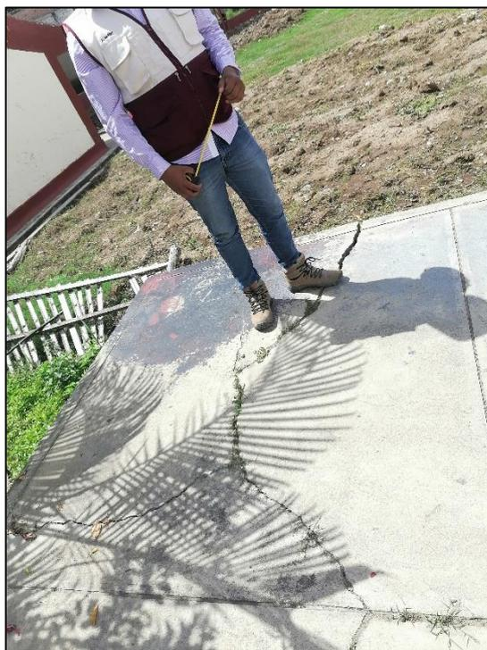
**Fotografía 31:** Losa dividida de severidad media
