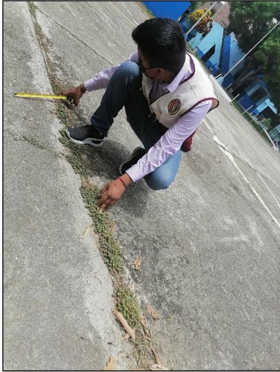
**Fotografía 24:** Daño del sello de la junta
