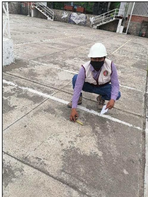
**Fotografía 46:** Grieta Lineal de severidad baja
