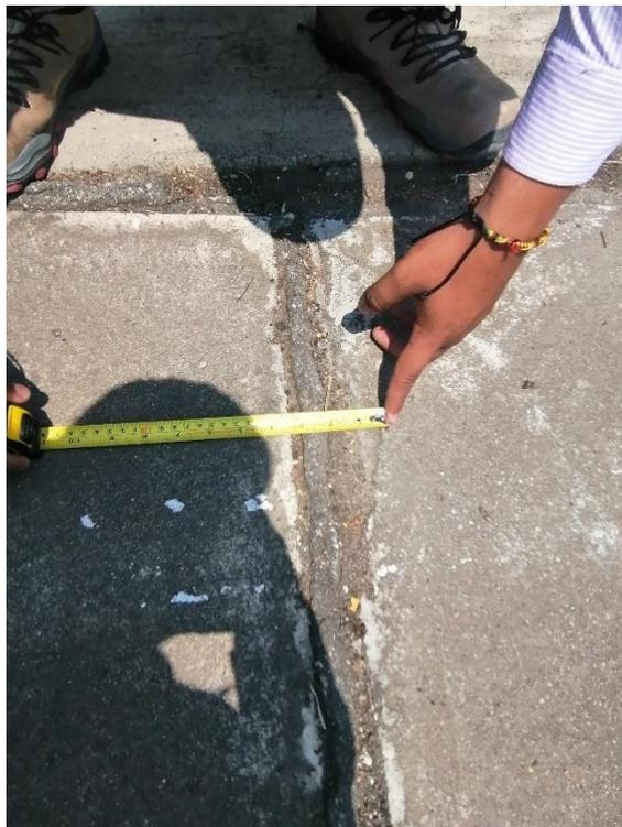
**Fotografía 06:** Descascaramiento de junta de severidad baja
