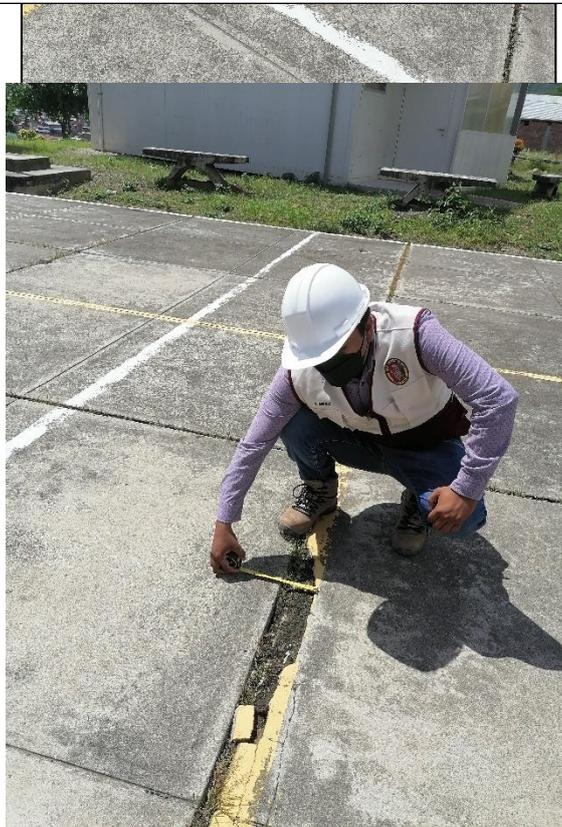
**Fotografía 54:** Descascaramiento de junta
