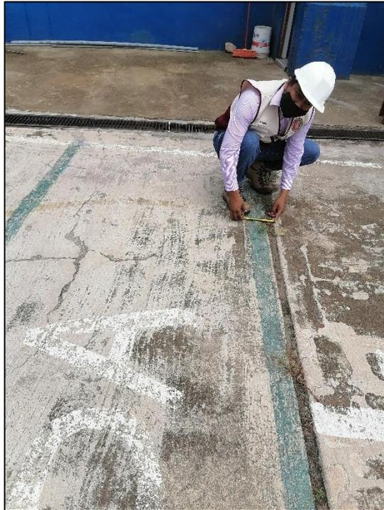
**Fotografía 44:** Descascaramiento de junta de severidad baja
