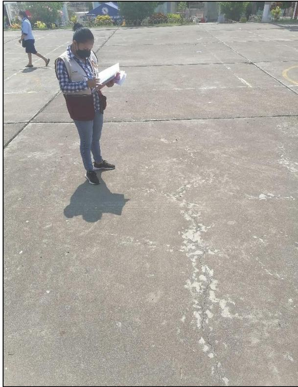
**Fotografía 03:** Losa dividida de severidad baja
