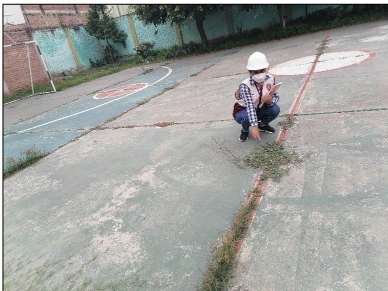
**Fotografía 55:** Daño del sello de la junta
