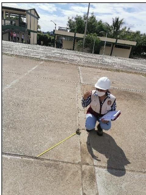
**Fotografía 27:** Losa dividida de severidad baja
