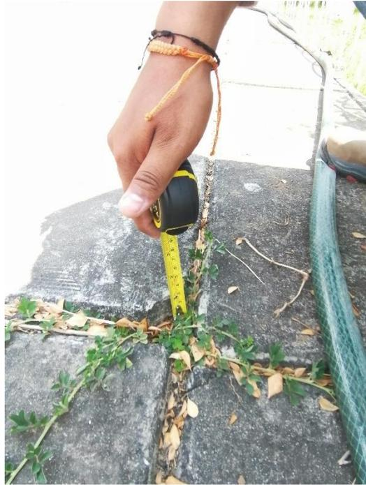
**Fotografía 07:** Descascaramiento de esquina de severidad media
