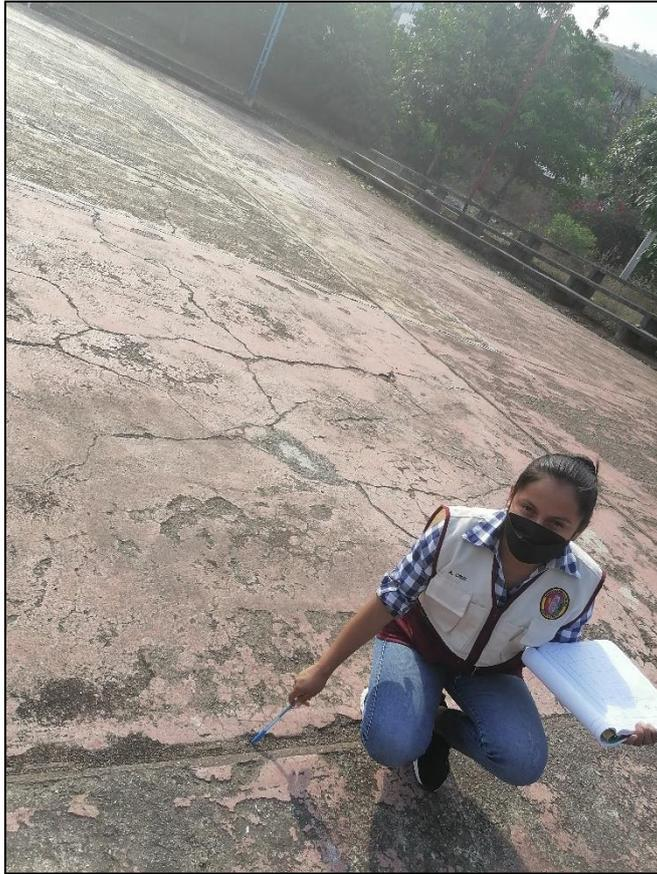
**Fotografía 14:** Descascaramiento de junta de severidad media
