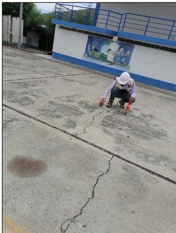
**Fotografía 37:** Losa dividida de severidad baja
