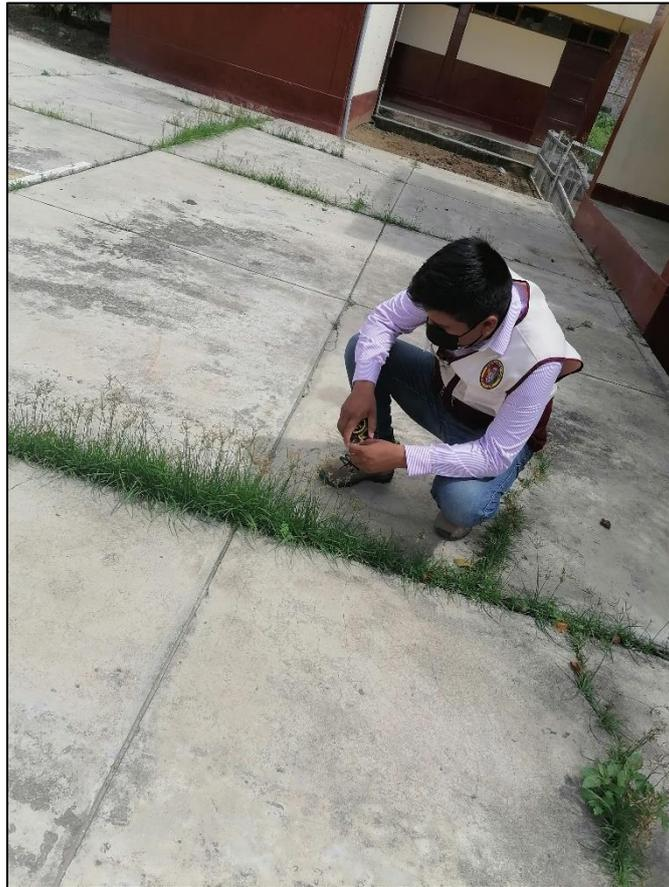
**Fotografía 32:** Daño del sello de la junta
