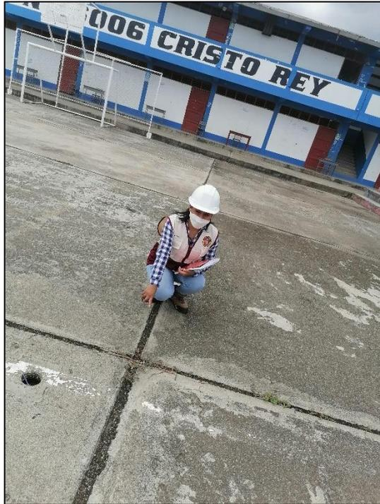
**Fotografía 38:** Daño del sello de la junta
