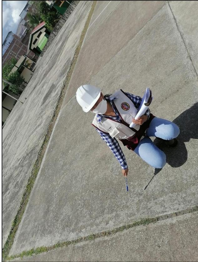
**Fotografía 28:** Daño del sello de la Junta
