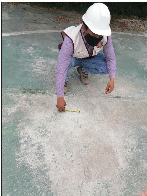
**Fotografía 56:** Grietas lineales de severidad baja
