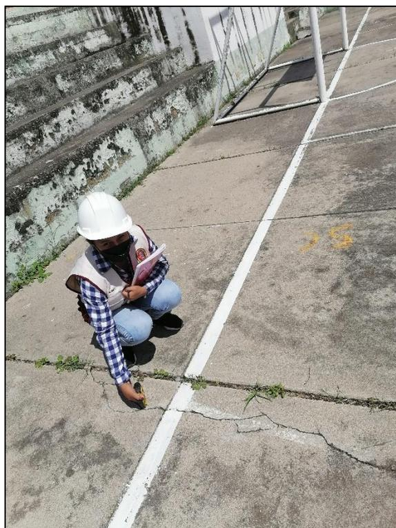
**Fotografía 52: Grietas lineales de severidad media**
