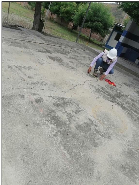
**Fotografía 41:** Grietas lineales de severidad baja
