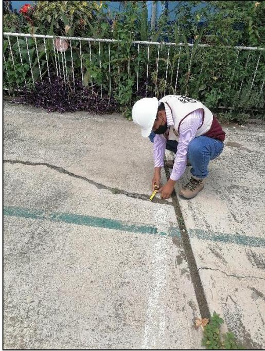
**Fotografía 43:** Grietas lineales de severidad media
