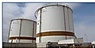
Tanques de combustible Diesel B5
