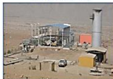
Central Termoeléctrica Huaycoloro
