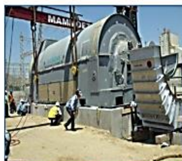
Montaje de Turbina a Gas y Generador
