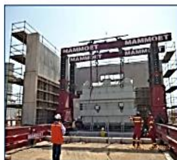
Montaje del Transformador de Potencia Concluido
