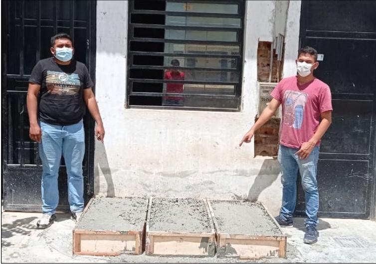
*Nota:* En la figura 12, se muestran tres de las cinco secciones de pavimento de concreto permeable elaborados sin agregado fino, se calculó el volumen de cada sección de pavimento y se elaboró en la mezcladora de concreto con las proporciones de diseño establecidas en la etapa 1 correspondientes al concreto sin agregado fino.
