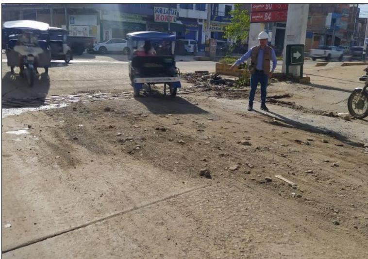
*Nota:* En la figura 10, se observa el proceso de identificación de sedimentos en la calle Sacsayhuamán, el procedimiento consistió en medir la altura de los sedimentos en cinco puntos diferentes en la zona donde se identificaron los sedimentos, para esta calle la altura promedio del nivel de sedimentos fue de 5.30 cm.
