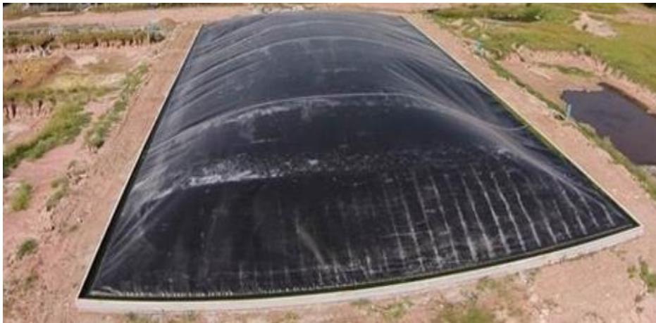
Biodigestor laguna cubierta
