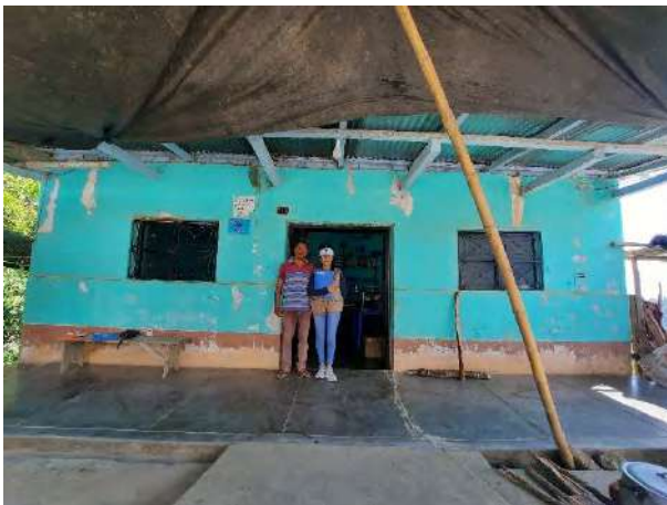
Vivienda N° 50 con vulnerabilidad media en calle San Martín.
