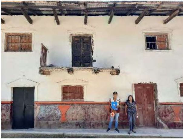
Vivienda N° 15 con vulnerabilidad alta en AV. Francisco Bolognesi.
