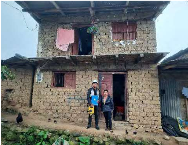
Vivienda N° 22 con vulnerabilidad alta en AV. Francisco Bolognesi.
