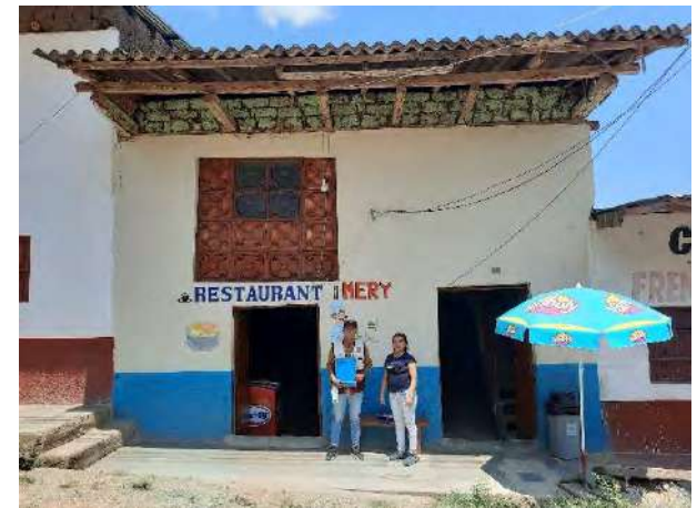
Vivienda N° 22 con vulnerabilidad media en calle San Martín.
