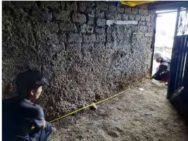
Obtención de medidas con apoyo de pobladores del caserío de la Coipa.
