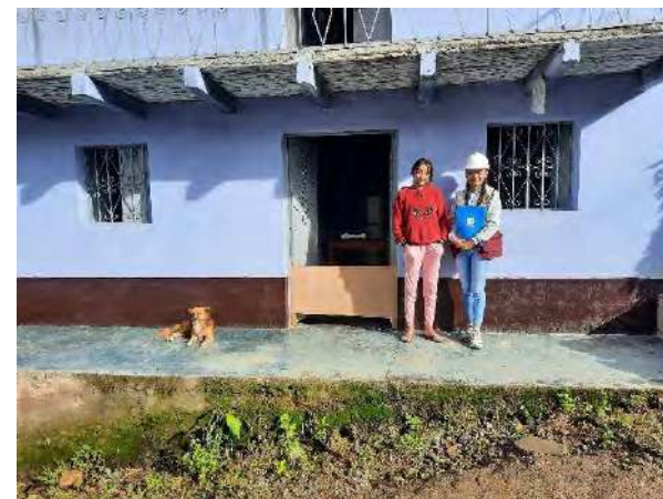
Vivienda N° 08 con vulnerabilidad media en calle San Martín.
