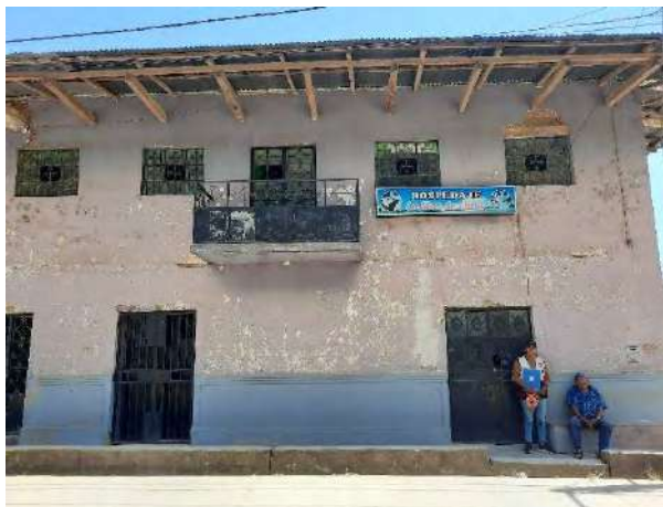
Vivienda N° 08 con vulnerabilidad media en calle San Martín.
