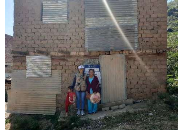
Vivienda N° 07 con vulnerabilidad media en calle Projectada.
