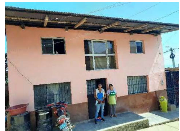
Vivienda N° 34 con vulnerabilidad media en AV. San Martín.
