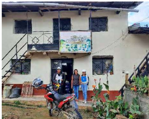
Vivienda N° 23 con vulnerabilidad alta en AV. Francisco Bolognesi.
