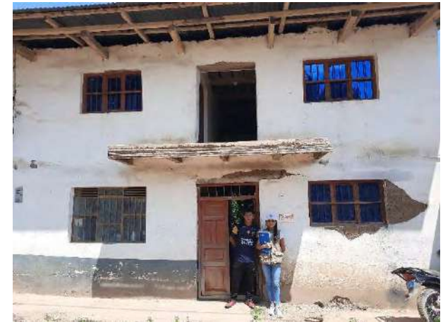
Vivienda N° 02 con vulnerabilidad alta en calle Miguel Grau.
