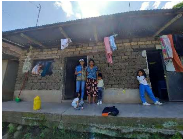
Vivienda N° 45 con vulnerabilidad alta en calle San Martín.
