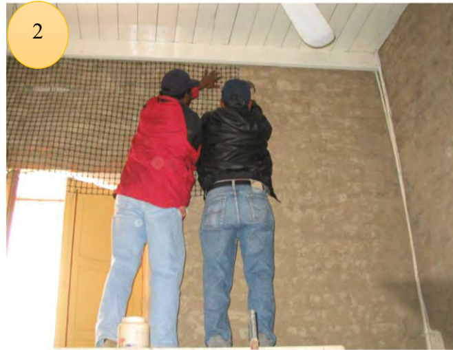
APLICACIÓN DE LA GEOMALLA BIAXIAL
