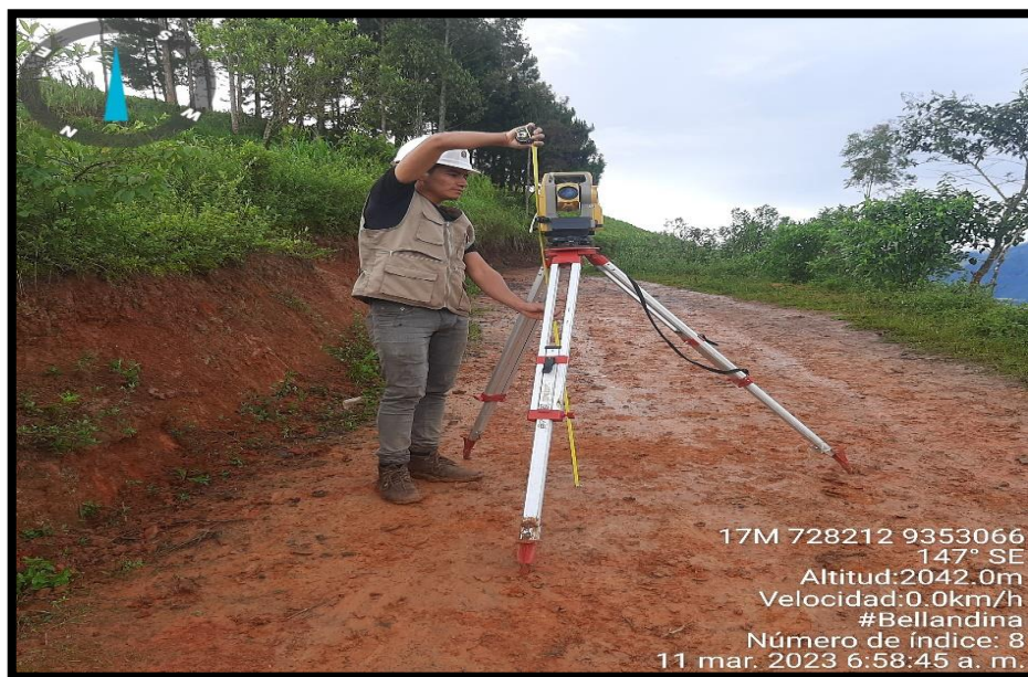
Medición de la Altura del Equipo
