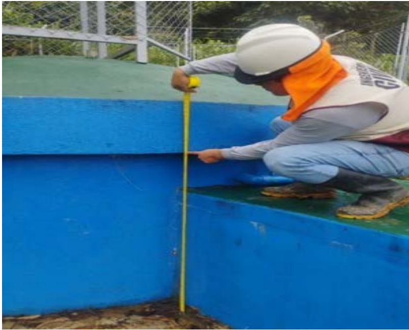
Imagen 11: Sacando medidas del reservorio
