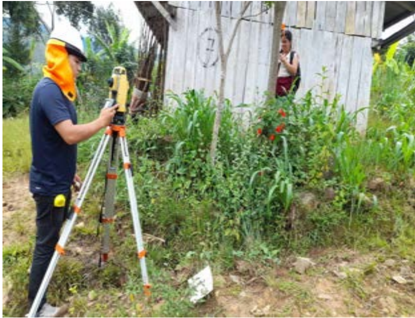
Imagen 5: Levantamiento topográfico de viviendas
