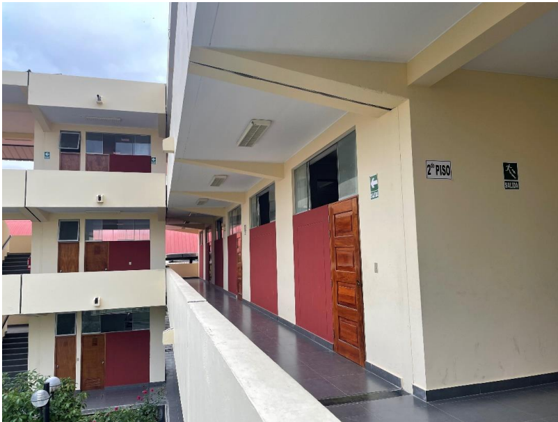
Vista Lateral del 2do Piso del Bloque 3D
