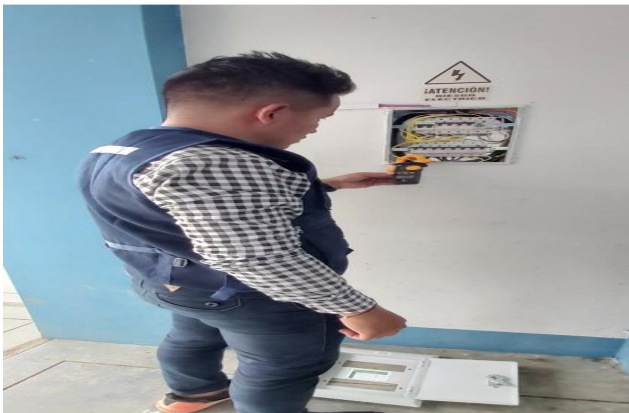
Figura N°61: Realizando el diagnóstico con la Pinza Amperimétrica a los Tableros de la I.E.S.
