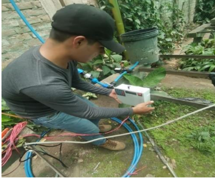
Figura 36. Instalación de la caja de paso.
