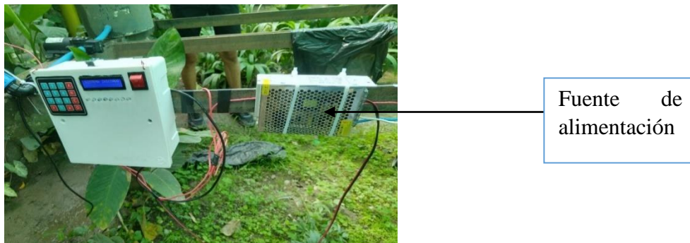
Figura 37. Instalación de fuente de alimentación.
