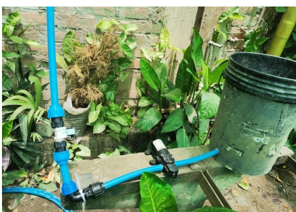
Figura 35. Instalación de bomba de agua
