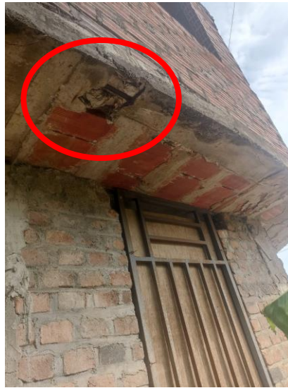
Armadura de viga solera
