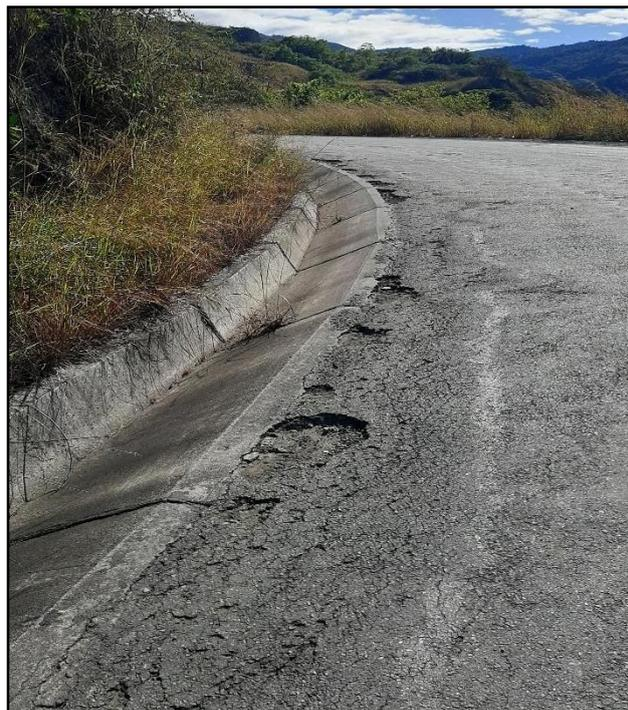
**Figura 80.** *Falla: Erosión Y Desprendimiento De Agregados.*
