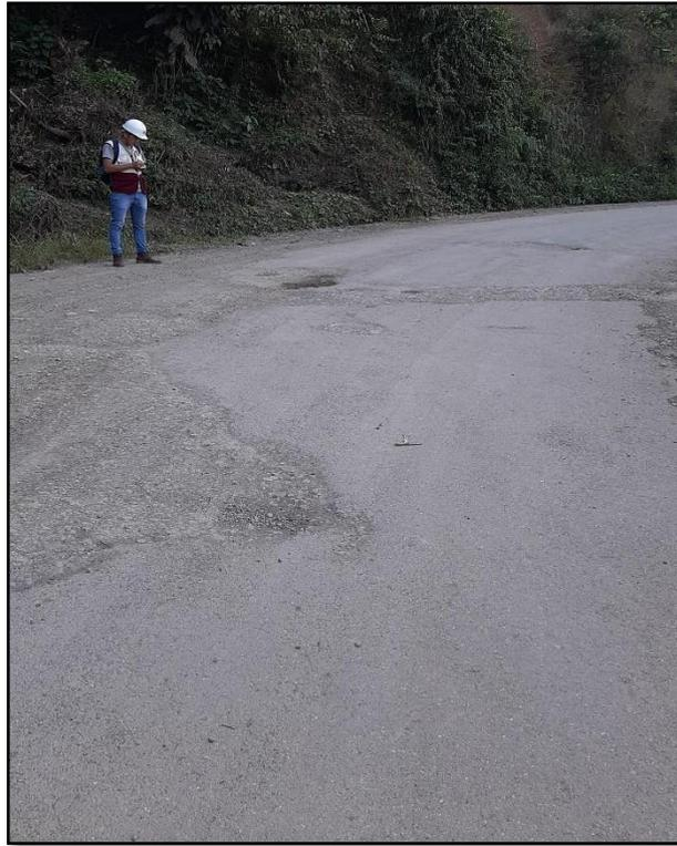
**Figura 59.** *Falla: Desintegración Por Baches Y Desprendimiento De Agregados.*
