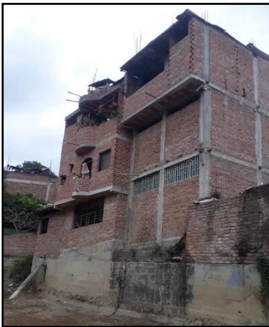
*Nota.* En la figura 8, se observa construcciones de viviendas sobre los muros de contención de la zanora exponiendo a la población a sufrir daños por inundación fluvial.
