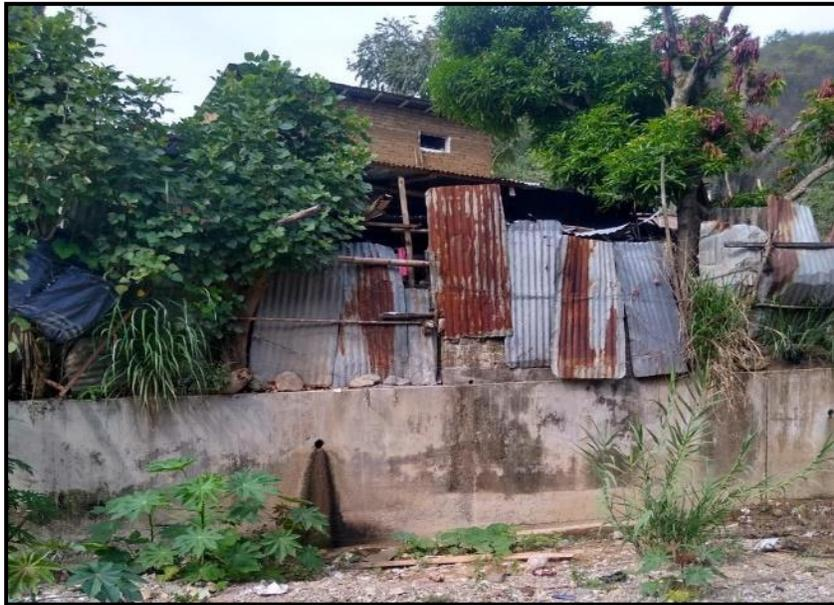
*Nota.* En la figura 5, se observa los muros de contención en mal estado, exponiendo a la población del Sector Magllanal.
