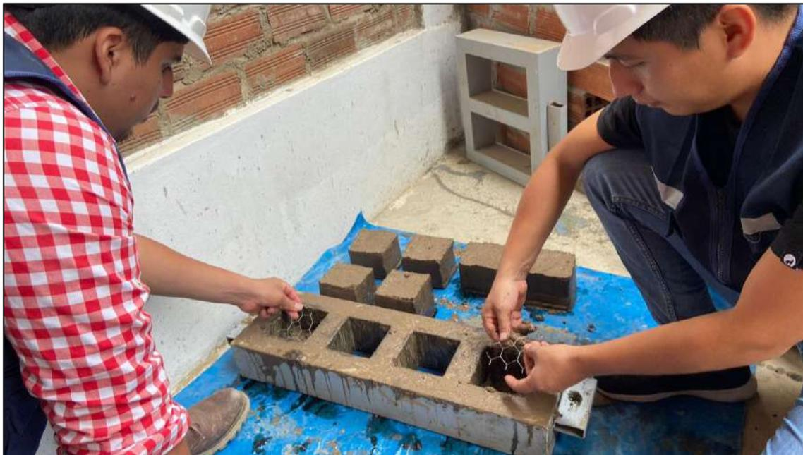
*Nota.* La figura muestra la mezcla de suelo con 1MH + 5% ARM para la fabricación de adobes 0.10mx0.10mx0.10m.
