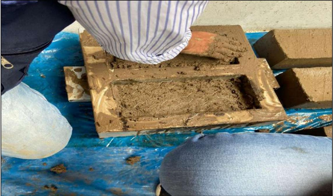
*Nota.* La figura muestra la mezcla de suelo con 1MH+10% ARM para la fabricación de adobes 0.15mx0.30mx0.12m.
