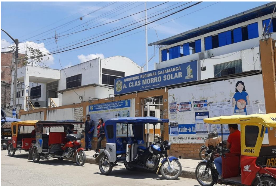
Figura 1: Centro Salud Morro Solar Jaén, ubicado en el Departamento de Cajamarca, Provincia Jaén, Distrito Jaén.
