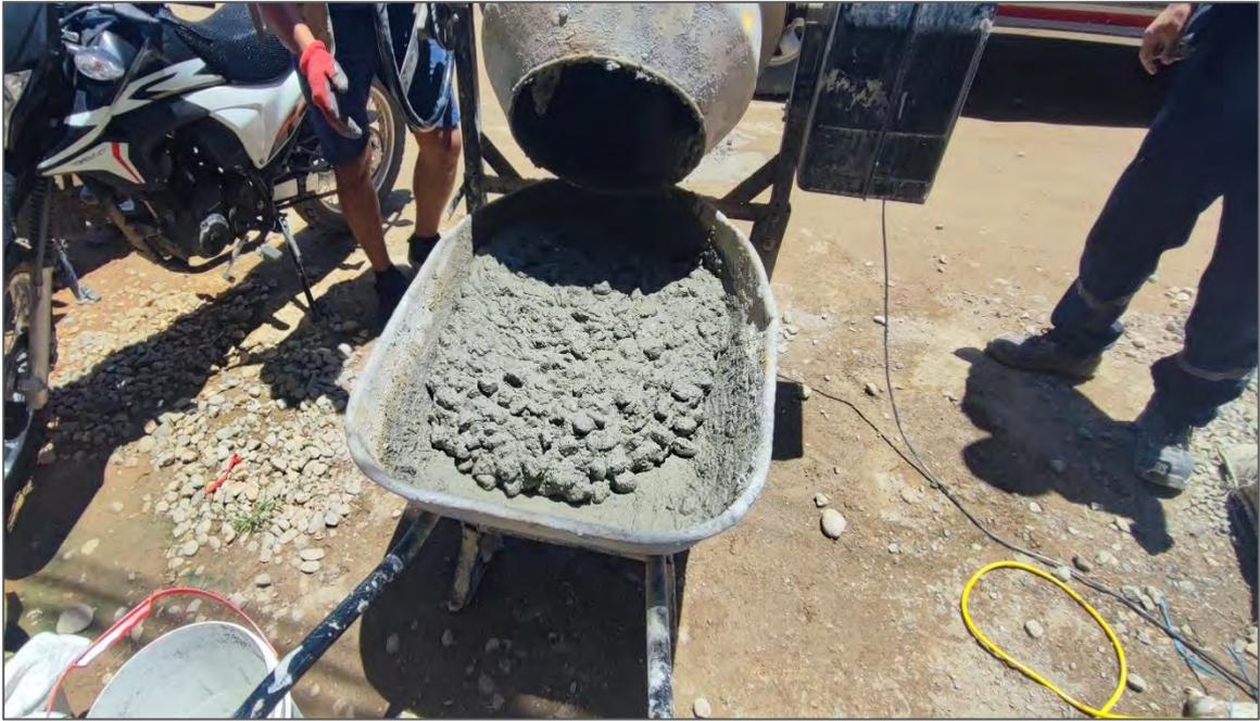
*Nota.* La figura muestra la dosificación de concreto patrón  $f'c=210\text{ kg/cm}^2$ . Fuente: Elaboración propia.
