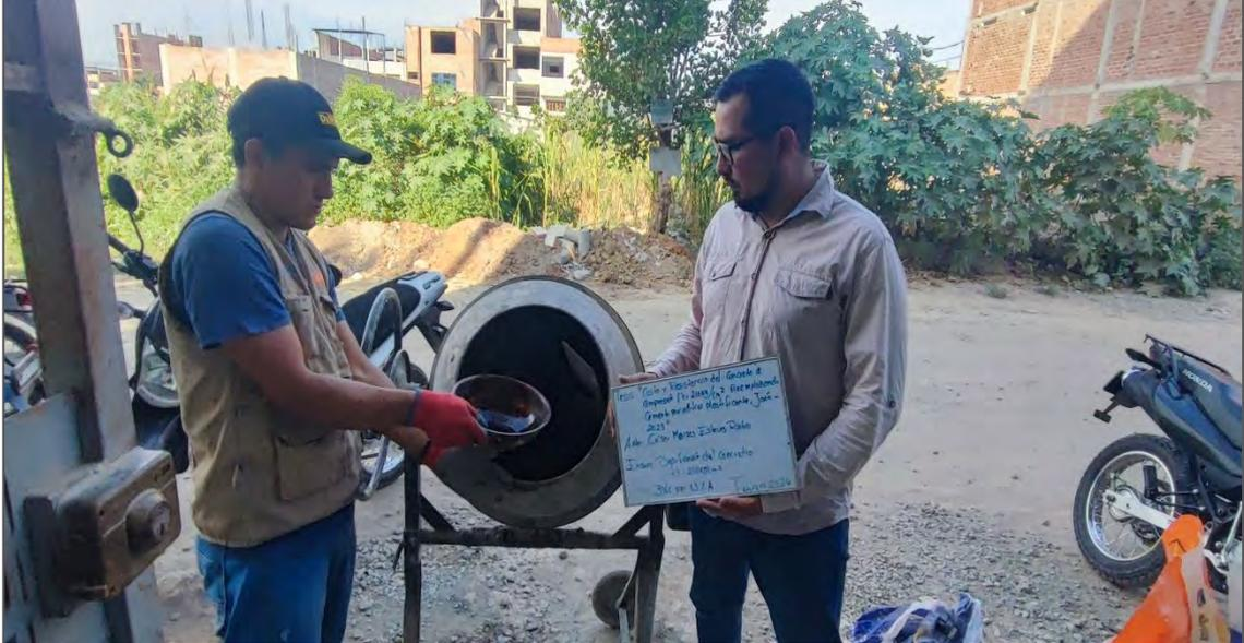
*Nota.* La figura muestra la dosificación de concreto  $f'c=210\text{ kg/cm}^2$ , reemplazando 3% de cemento por 1.5% de aditivo. Fuente: Elaboración propia.
