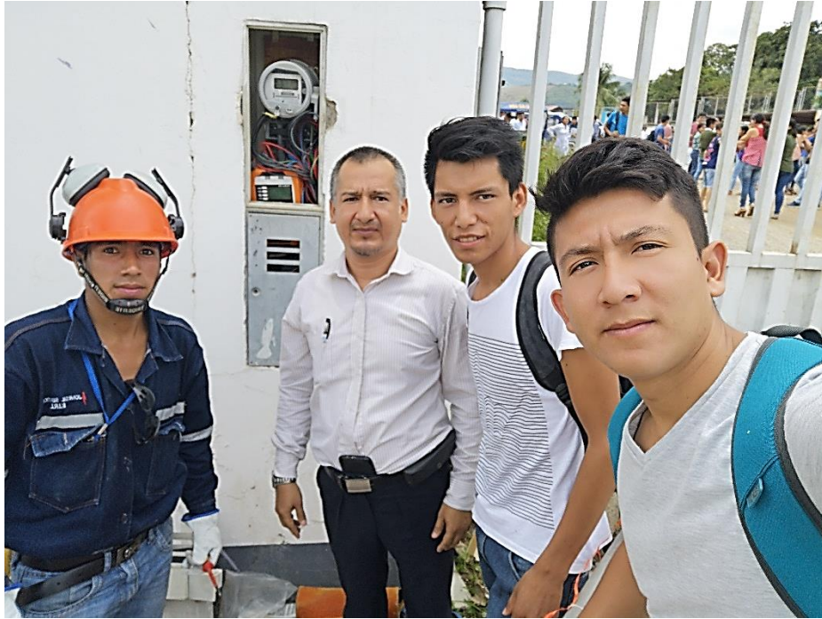
Figura 27. Instalación del analizador de redes.
