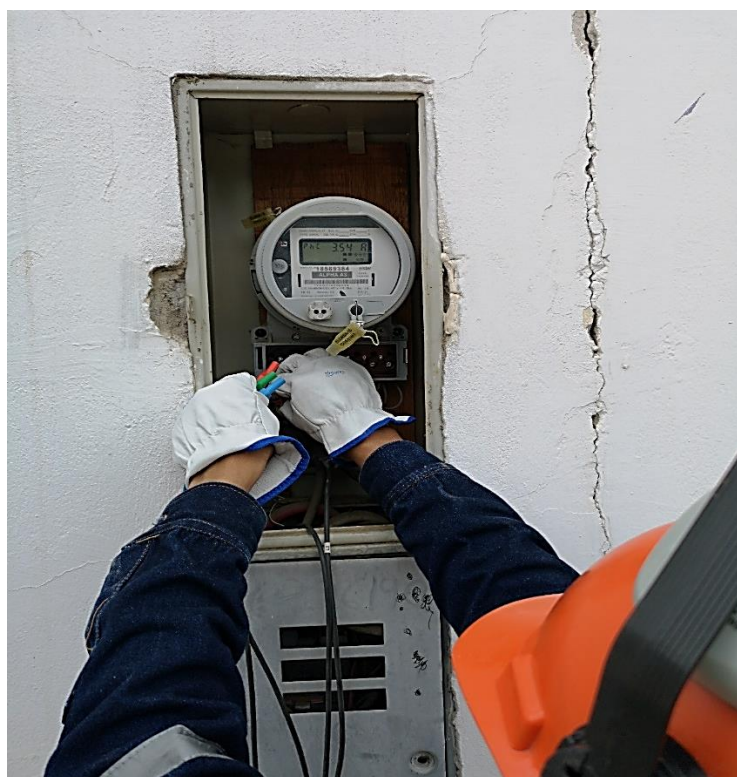
Figura 24. Instalación del analizador de redes.
