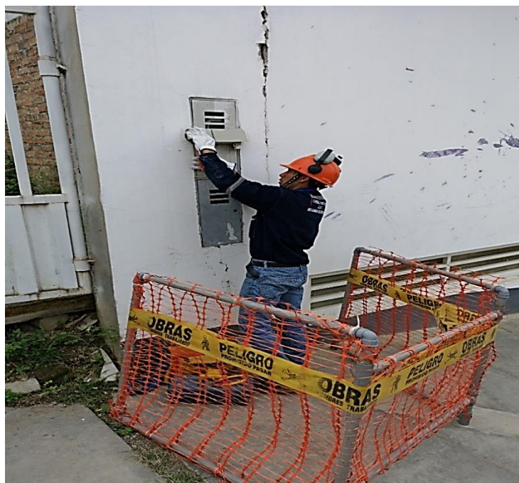
Figura 23. Señalización del área para instalación del Analizador de redes.
