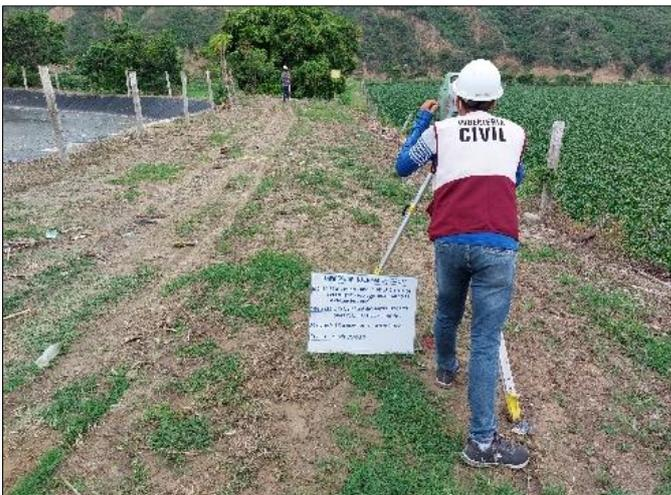
*Nota:* En las figuras 1 y 2, se muestra el proceso de levantamiento topográfico realizado con estación total, la primera imagen corresponde el tramo de ingreso a las lagunas de oxidación, mientras que, la segunda figura corresponde al interior de las lagunas de oxidación.
