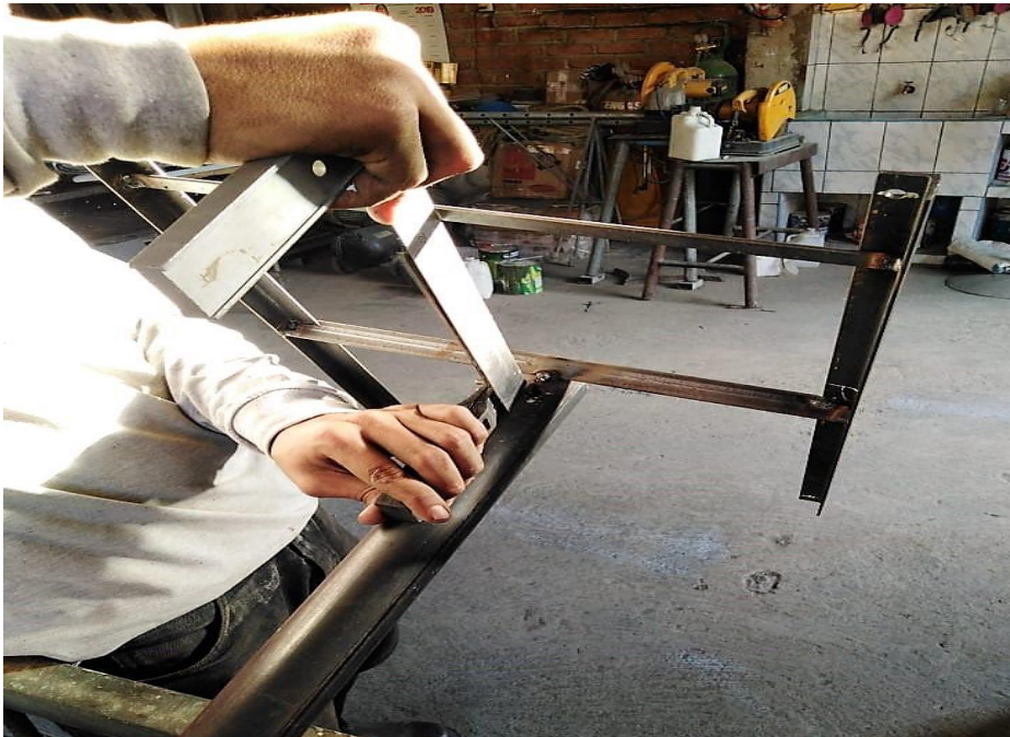
Figura 20. Medición de inclinación de panel a 5°
