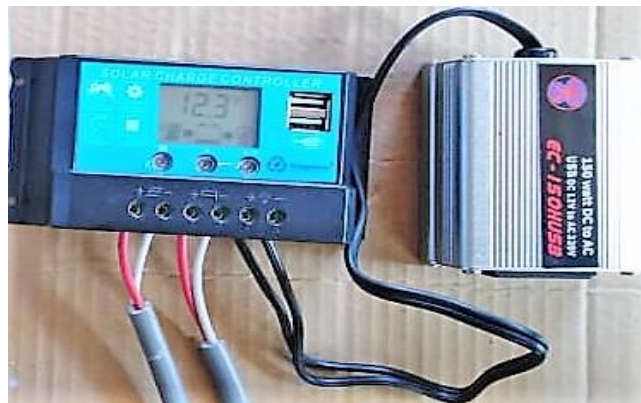
Figura 11. Conexión del inversor con el regulador
