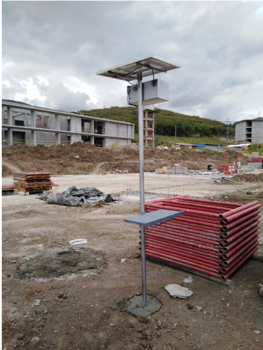
Figura 25. Instalación del cargador solar prototipo
