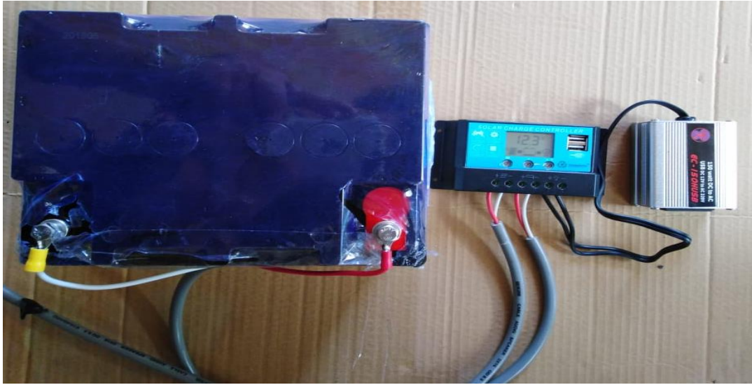
Figura 23. Instalación de los componentes del cargador solar prototipo
