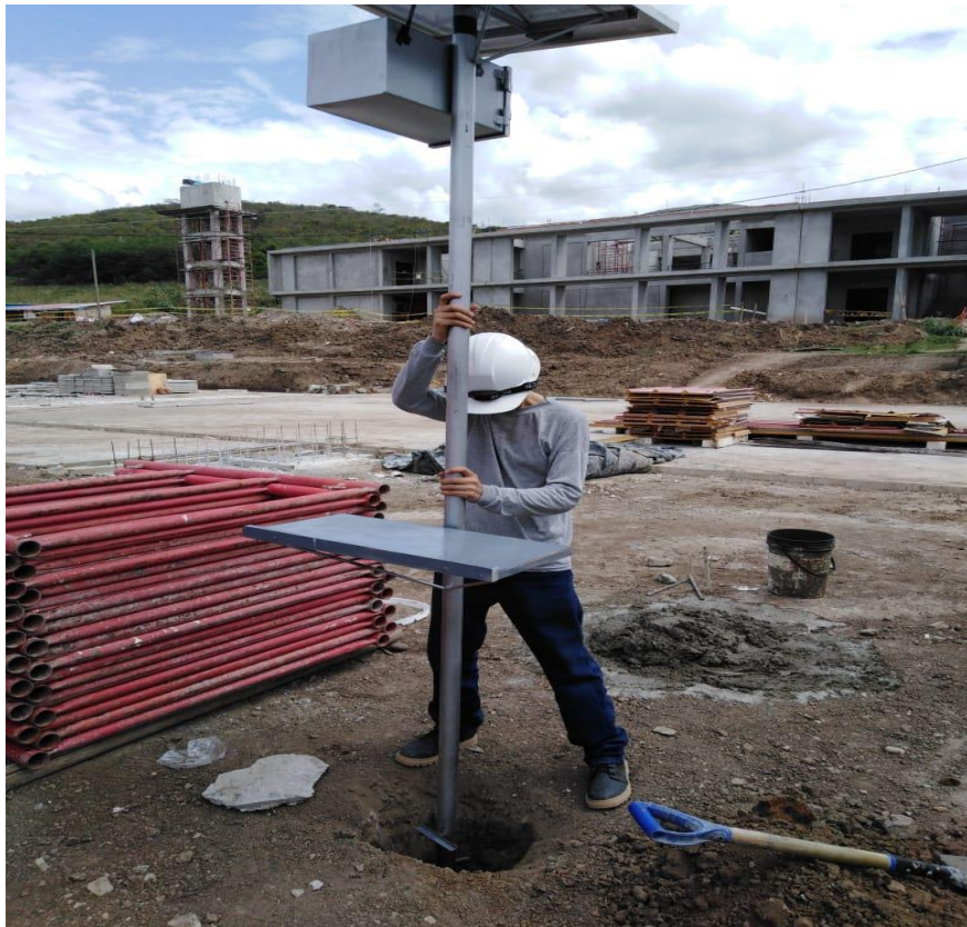
Figura 24. Izado de la estructura de cargador solar
