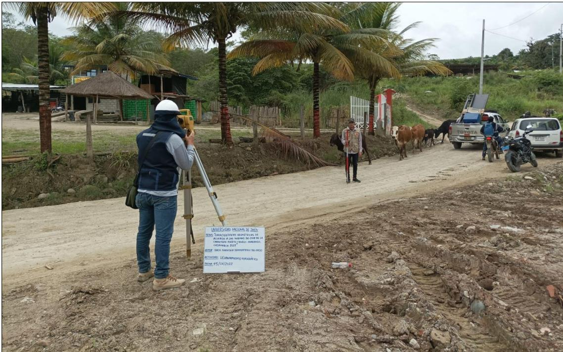
*Nota: Elaboración propia***Figura 29***Levantamiento topográfico, medición de la altura de la estación total*
