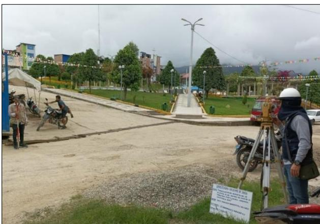
*Nota:* En la figura 6, se presenta la realización del levantamiento topográfico.
