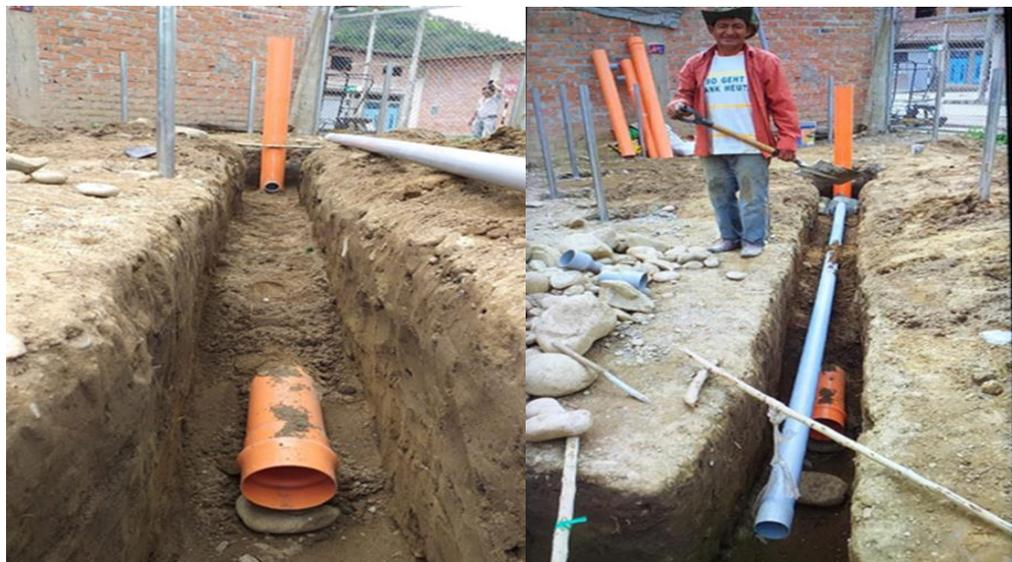
**Figura 3.** Tubería que alimenta los módulos de cultivo
