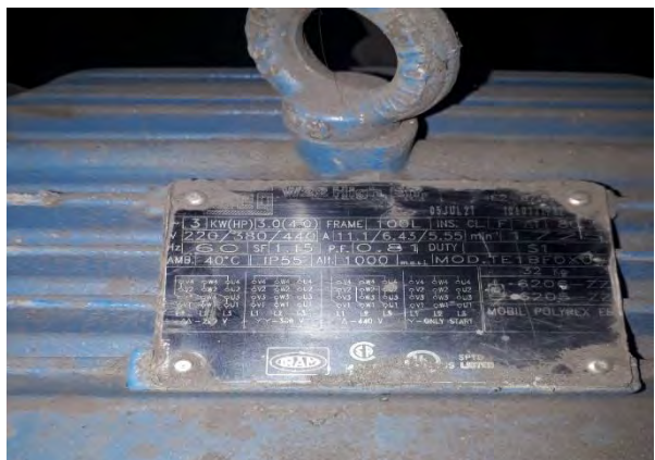
FOTO N°: Verificación de motores eléctricos, en los cuales se detalla la placa característica de operación 07
