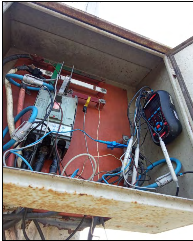
Instalación de analizador de redes para verificar la calidad de la energía de la Empresa Cerámicos Prisma S.A.C.
