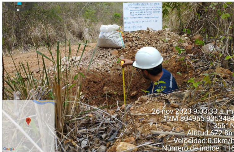
Medición de profundidad de calicata N° 2
