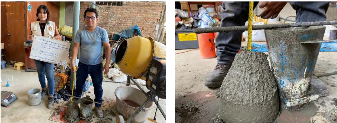
*Nota.* La figura muestra la medición del asentamiento del concreto. Fuente: Normativa NTP 339.035.
