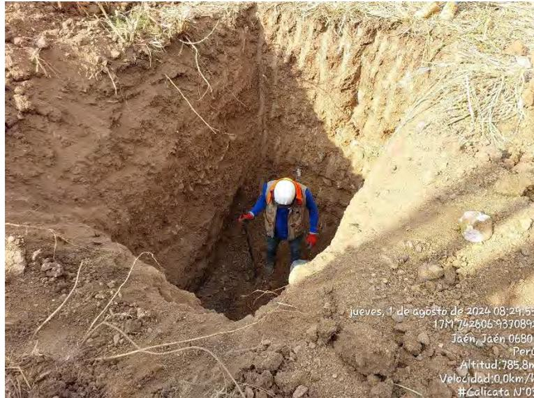
Nota: Extracción de muestras de la calicata para ensayos de laboratorio.
