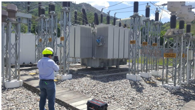
Figura 8. Toma de medición del transformador de potencia – hora 13:00 horas
