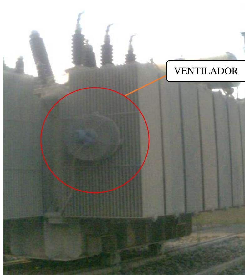
Figura 7. Ventilador instalado en los radiadores del transformador de potencia 20 MVA
