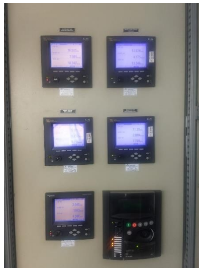
Figura 5. Tablero de control
