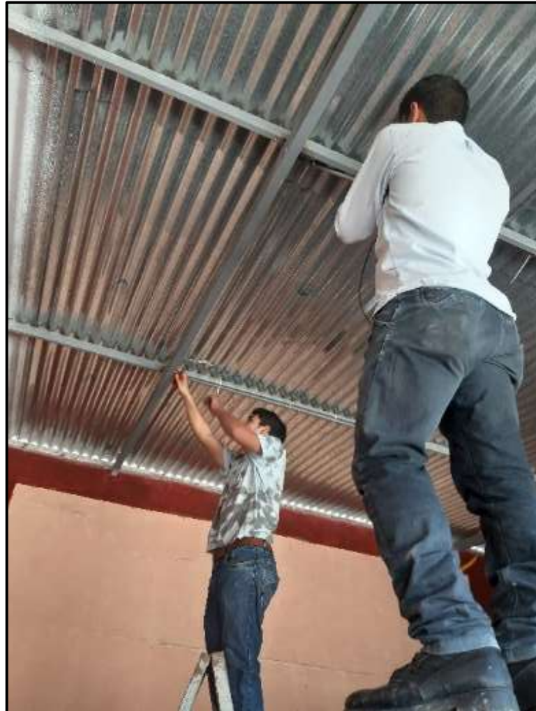
Figura 8. Instalación del cableado
