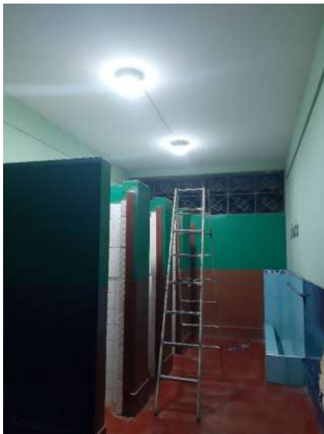
Baño varones del pabellón N° 02.
