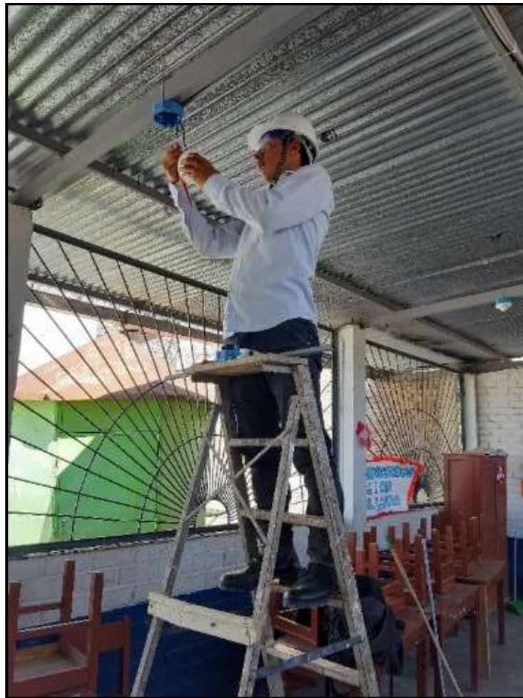
Figura 7. Colocación de la tubería y cajas octogonales.
