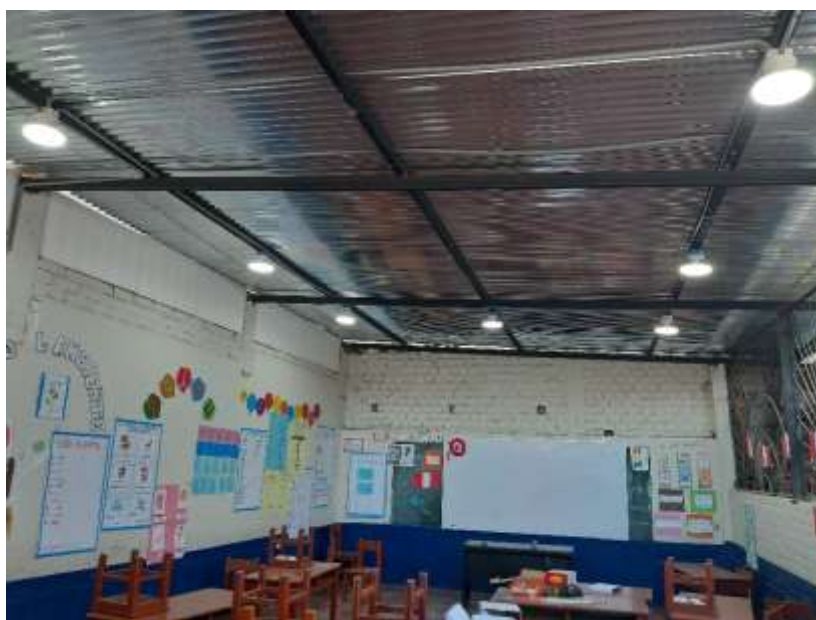
Aula N° 01 del pabellón N° 03
