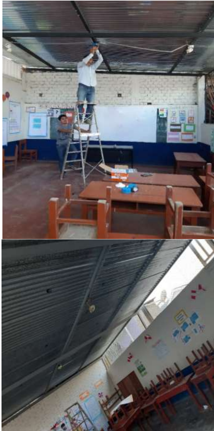
Figura 19. Desinstalación del sistema de iluminación convencional.
