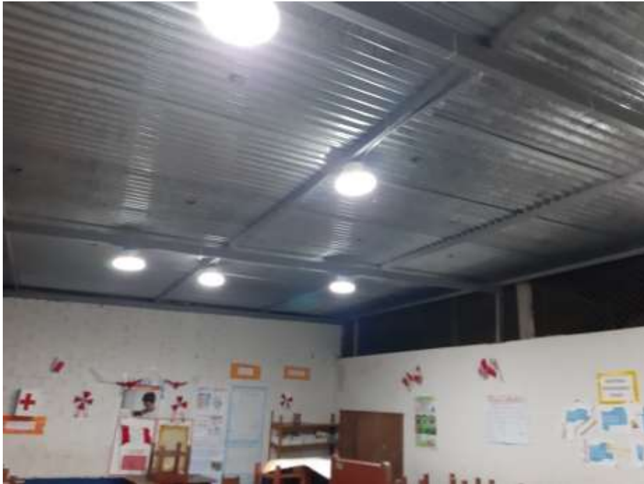
Aula N° 01 del pabellón N° 01
