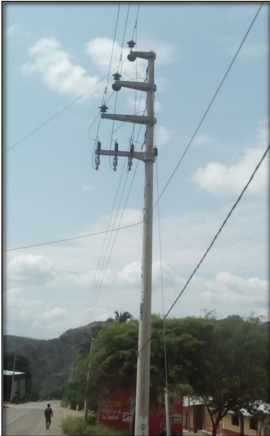
Estructura Seccionamiento de CENFROCAFE
