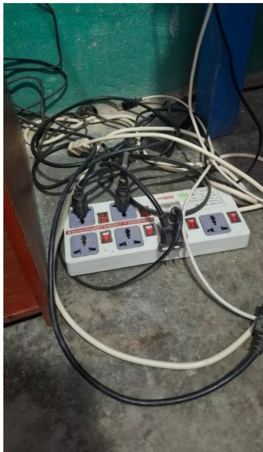
En las Aulas de clase detectó sobrecargas de los circuitos eléctricos, falta de independización de circuitos y las instalaciones eléctricas no cumplían con el Código Nacional de Electricidad (CNE).
