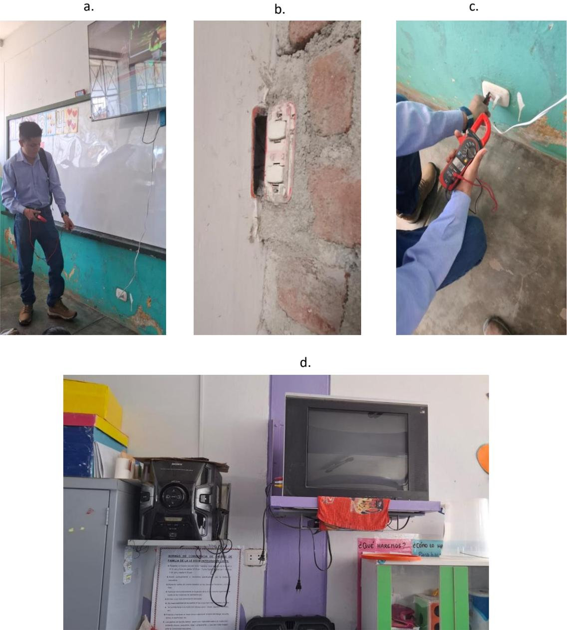
Ausencia de un tablero general de cargas balanceadas en la I.E.I019 Montegrande que cumpla con el CNE,
