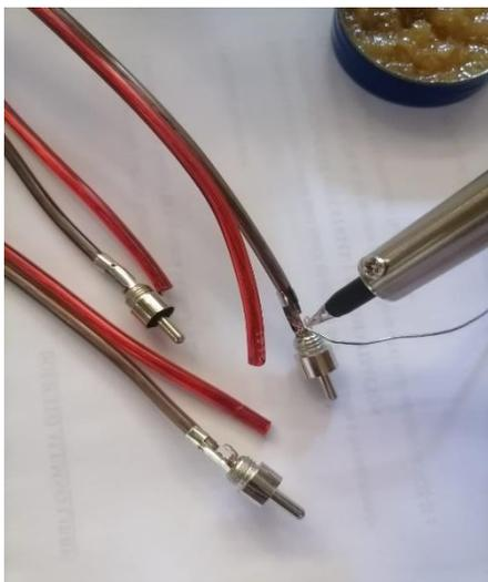
a) Soldadura de los conectores machos en el cable
