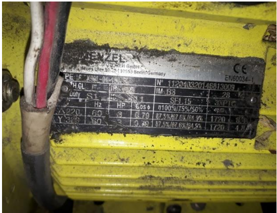
FOTO N°: Verificación de motores eléctricos, en los cuales se detalla la placa característica de operación 07
