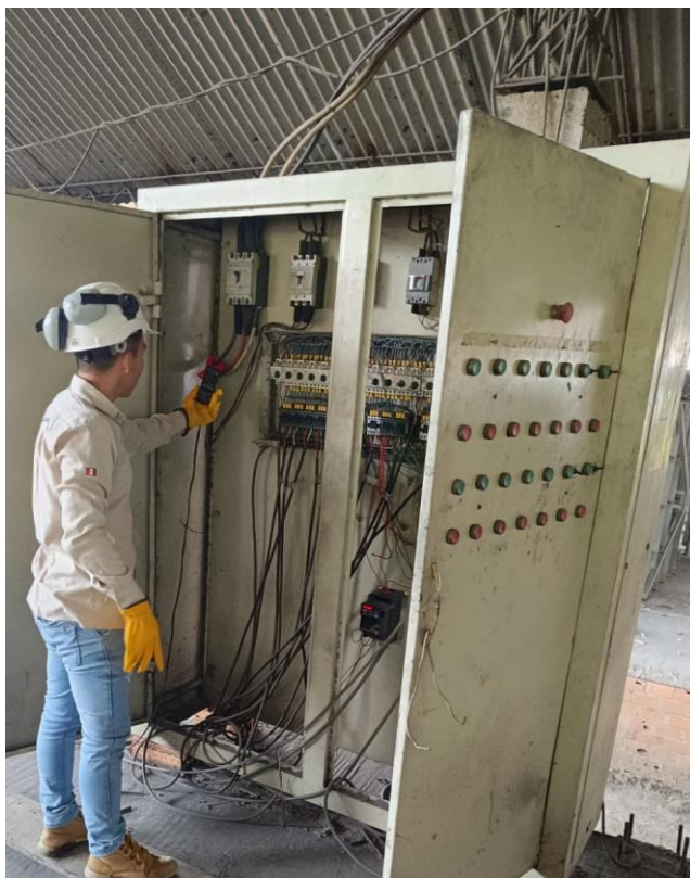
Toma de parámetro de corriente y voltaje en tableros de distribución con Pinza amperimétrica calibrado
