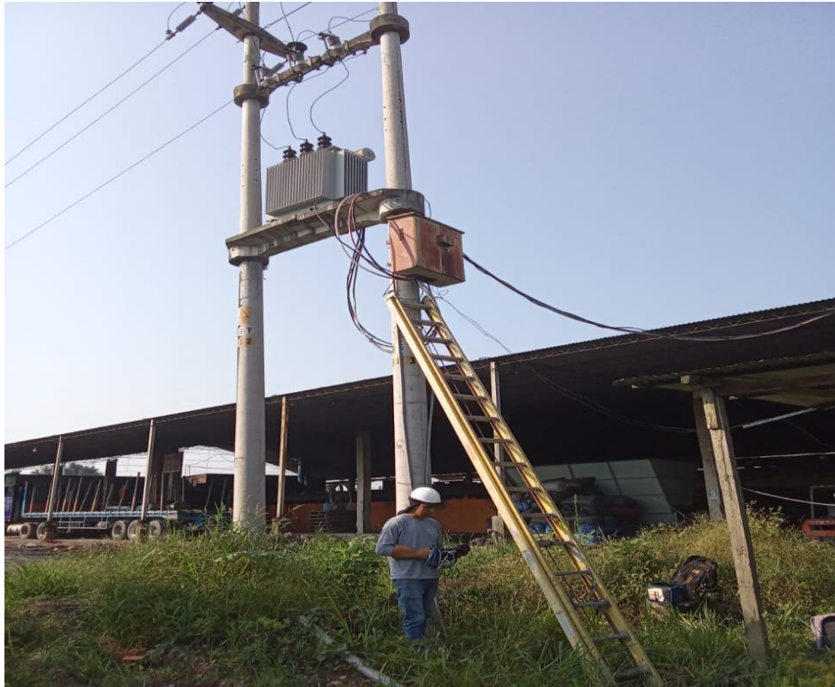
Instalación del analizador de redes en el tablero general
