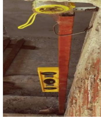
Figura 8. Verticalidad de columna
