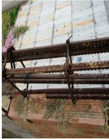
Figura 3. Acero desprotegido Figura 4. Acero desprotegido en columnas
