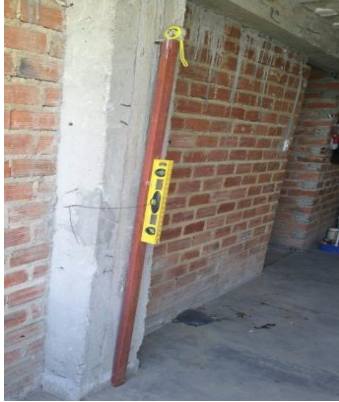
Figura 7. Verticalidad de columna
