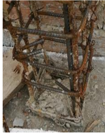
Figura 3. Acero desprotegido Figura 4. Acero desprotegido en columnas
