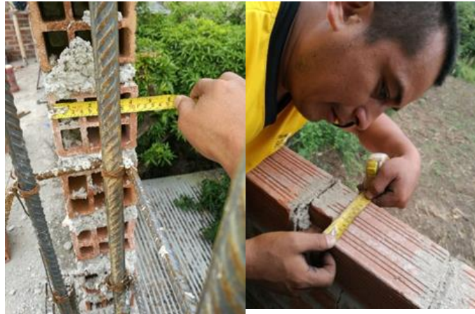
Figura 5. Pared no cumple con espesor mínimo
