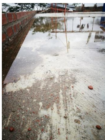
Figura 13. Detenimiento de agua
