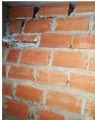
Figura 12 Juntas de muros
