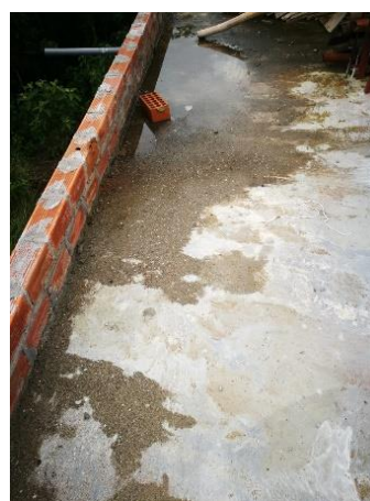
Figura 14. Detenimiento de agua
