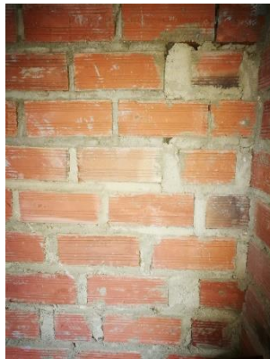
Figura 11. Juntas de muros
