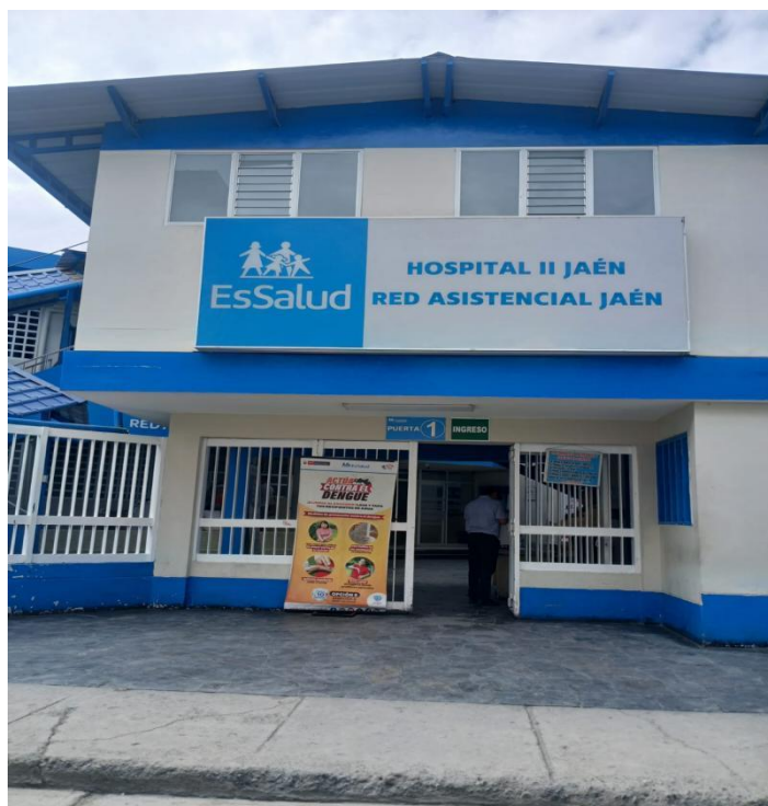
Foto 3: Fachada del Hospital II EsSalud ubicados en el distrito de Jaén distrito de Jaén región Cajamarca.
