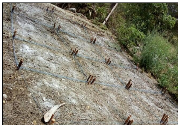
Fig. 16. Adición del encalante en el suelo.
