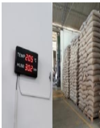
Figura 30: Medidor de temperatura y humedad del almacén
