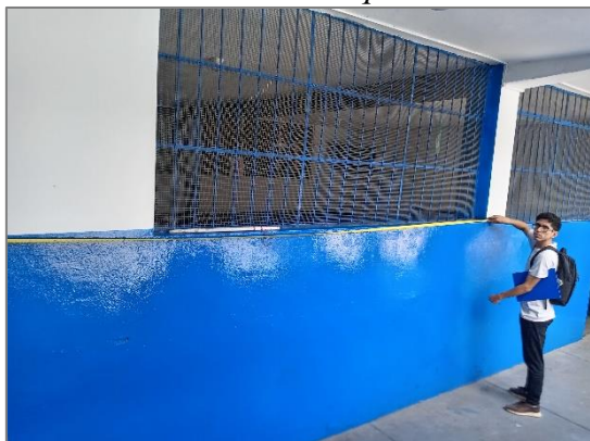
Toma de medidas del Bloque C
