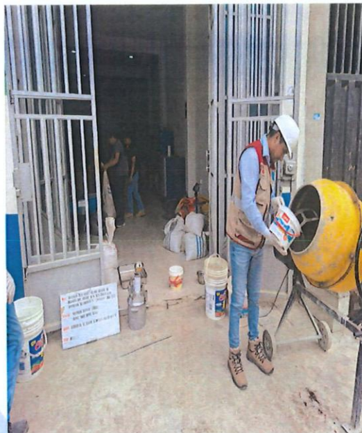
FIG. N° 26: DISEÑO DE MEZCLA 210 KG/CM2 + 4.5% R + 10.5% F
