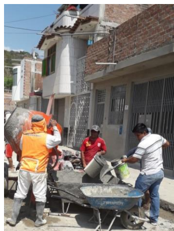
Figura 41. Muestreo de concreto en construcción informal 02
