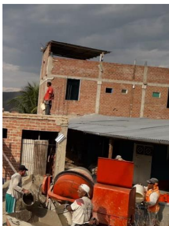
Figura 46. Dosificación de materiales en construcción informal 03
