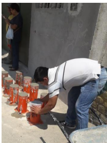
Figura 43. Elaboración de testigos de concreto en construcción informal 02
