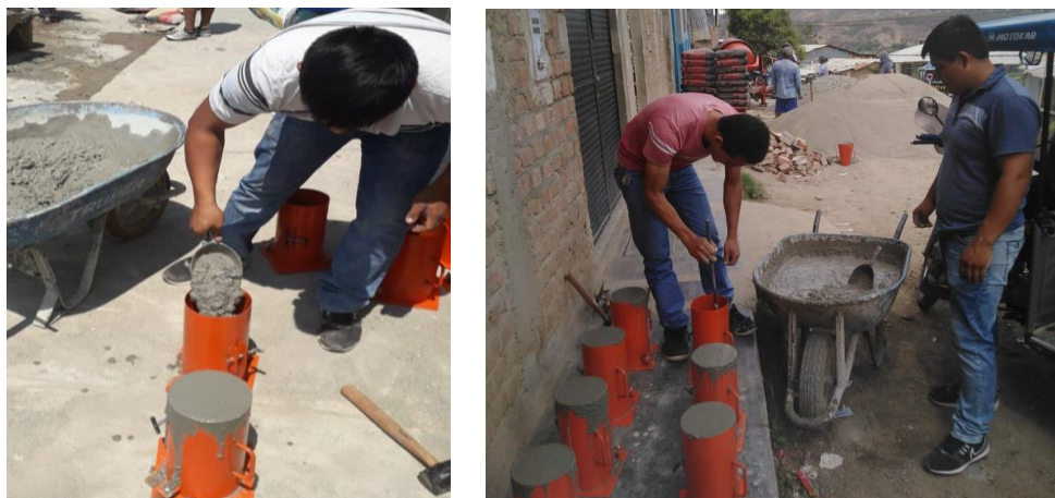
Figura 7. Figura 8. Elaboración de testigos de concreto.
