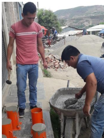
Figura 61. Elaboración de testigos de concreto en construcción informal 05
