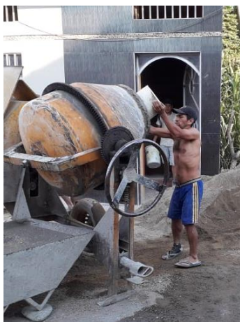
Figura 52. Dosificación de materiales en construcción informal 04
