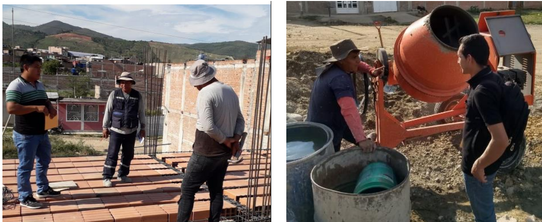
Figura 20. Figura 21. Difusión de recomendaciones básicas para elaboración de concreto a ser utilizado en losas aligeradas.
