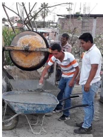
Figura 54. Muestreo de concreto en construcción informal 04
