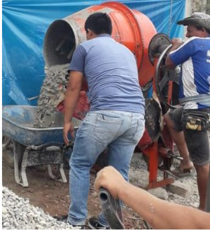
Figura 3. Figura 4. Toma de muestra de concreto.
