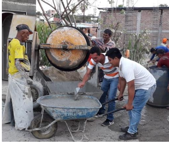
Figura 3. Figura 4. Toma de muestra de concreto.
