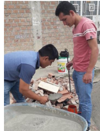
Figura 59. Asentamiento del concreto en construcción informal 05
