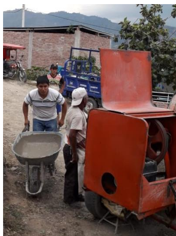
Figura 48. Muestreo de concreto en construcción informal 03
