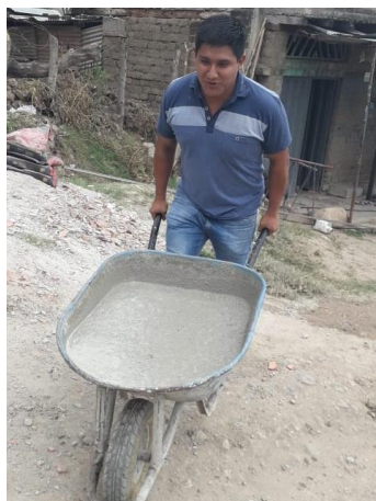
Figura 36. Muestreo de concreto en construcción informal 01
