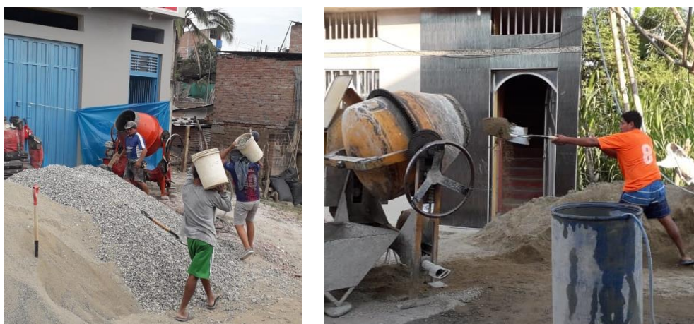
Figura 1. Figura 2. Proceso de dosificación de materiales.
