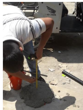
Figura 42. Asentamiento del concreto en construcción informal 02
