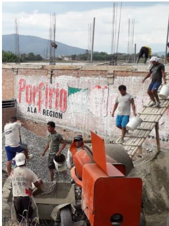
Figura 58. Dosificación de materiales en construcción informal 05
