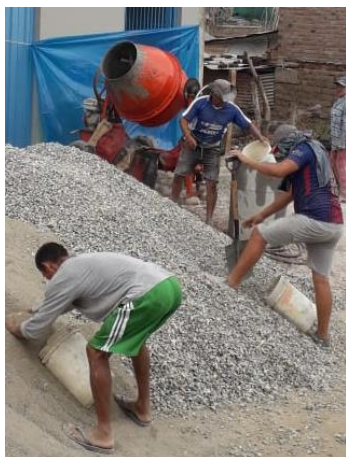
Figura 35. Dosificación de materiales en construcción informal 01
