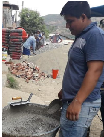
Figura 60. Muestreo de concreto en construcción informal 05
