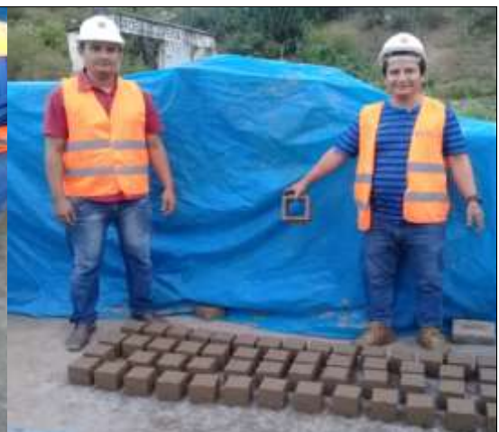
Figura 19. Adobes postrados sobre tendal de arena fina.
