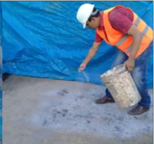
Figura 17. Tendal con arena fina donde van a reposar los adobes para el secado.
