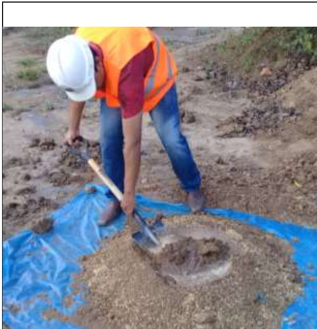
Figura 7. Batido de la mezcla para elaborar adobe.
