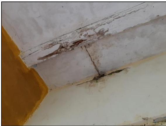
Figura 71. y Figura 72. Deterioro de materiales por filtraciones de agua de lluvia.
