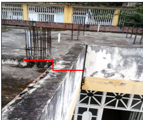
Figura 99. y Figura 100. Juntas deficientes entre módulos, causante de filtraciones de agua de lluvia en las edificaciones.
