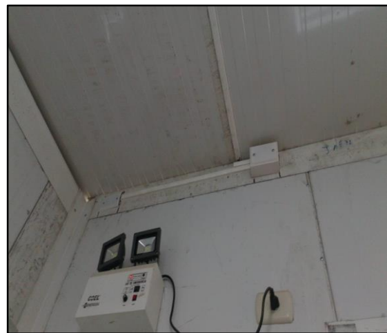
Figura 10. Se observa que los muros y el falso techo son de planchas metálicas.
