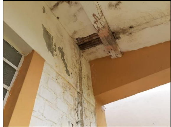
Figura 71. y Figura 72. Deterioro de materiales por filtraciones de agua de lluvia.
