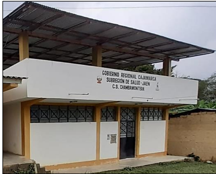
Figura 68. Cubierta de Calamina (Zinc) con vigas de madera.
