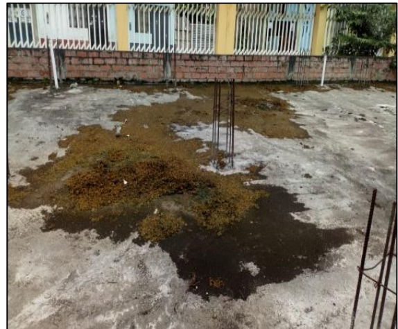
Figura 97. y Figura 98. Agua de lluvia acumulada y hongos en techo de losa aligerada, causantes de deterioro de losa por filtraciones.
