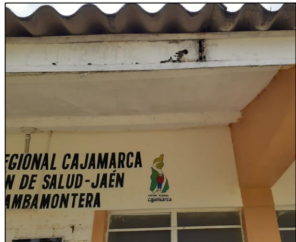
Figura 123. Figura 124. Falso techo en estado deteriorado.
