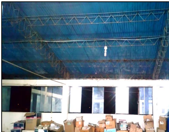
Figura 13. Cubierta de calamina con vigas tipo tijeral.
