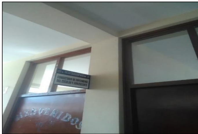
Figura 49. Conexión entre el diafragma y elementos estructurales es eficaz.
