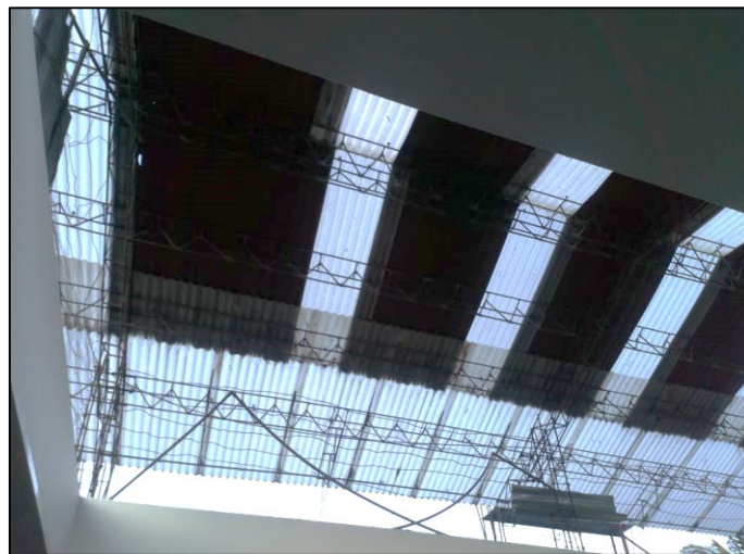
Figura 36. Cubierta de calamina.
