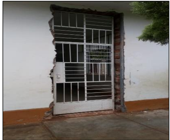
Figura 101. y Figura 102. Adaptación de puerta en uno de los muros.
