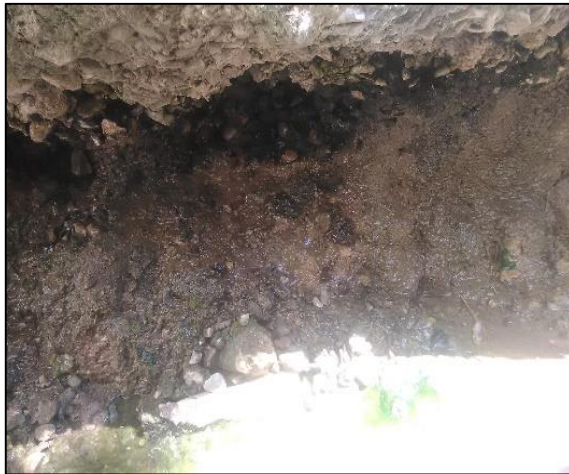
Figura 112 y Figura 113. Abundante afloramiento de agua subterránea hacia la superficie.
