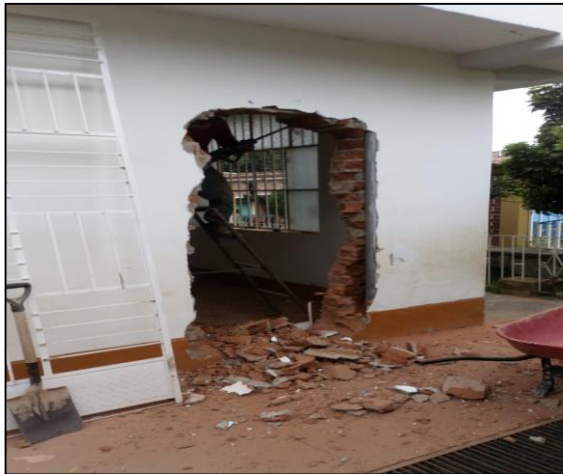
Figura 101. y Figura 102. Adaptación de puerta en uno de los muros.
