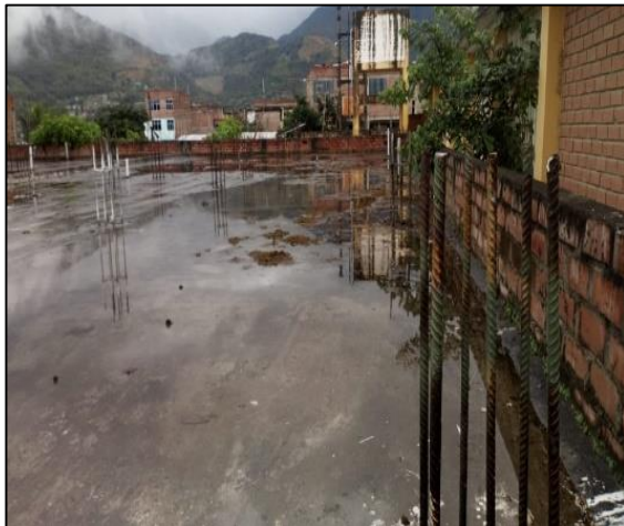
Figura 97. y Figura 98. Agua de lluvia acumulada y hongos en techo de losa aligerada, causantes de deterioro de losa por filtraciones.
