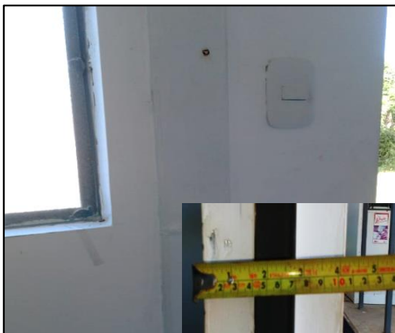
Figura 9. Muros de drywall y tubo cuadrado de acero para columnas.
