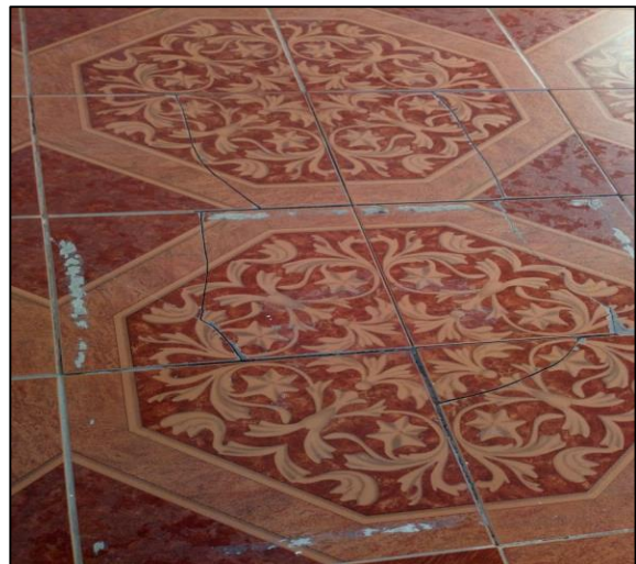
Figura 40. Levantamiento de cerámica en una parte de la edificación
