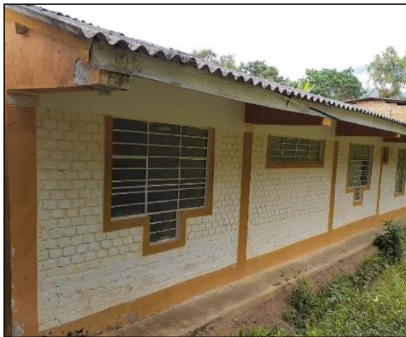
Figura 123. Figura 124. Falso techo en estado deteriorado.
