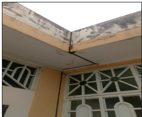
Figura 99. y Figura 100. Juntas deficientes entre módulos, causante de filtraciones de agua de lluvia en las edificaciones.
