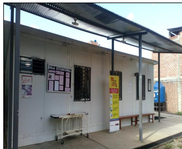
Figura 126. y Figura 127. Módulos de material prefabricado Drywall y planchas metálicas.
