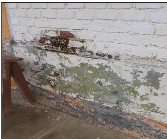
Figura 121. y Figura 122. Presencia de humedad en sobrecimientos.
