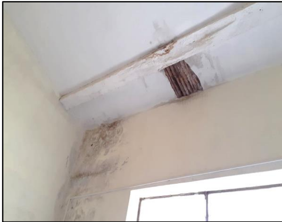
Figura 11. Losa de techo de caña brava con mortero y vigas de madera.
