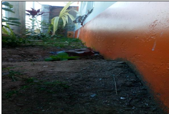
Figura 33. Empuje directo del suelo a la edificación.
