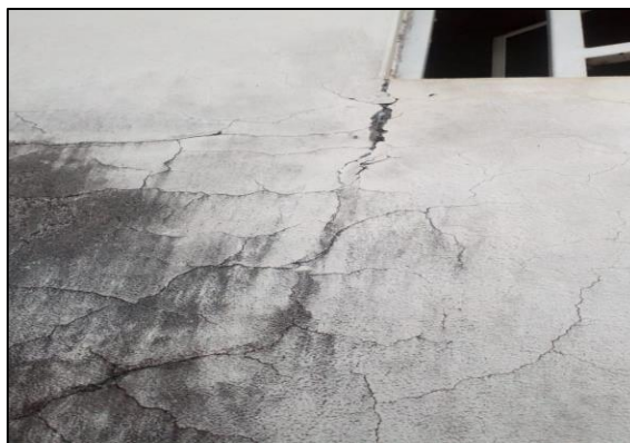
Figura 28. Humedad y desprendimiento del material en el muro.
