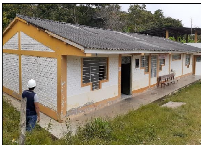
Figura 67. Cubierta de eternit.
