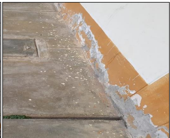
Figura 121. y Figura 122. Presencia de humedad en sobrecimientos.
